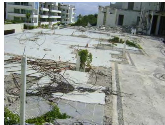
Edificios colapsados por hundimientos y/o cavidades debajo de la construcción.
