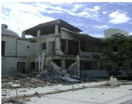
Edificios colapsados por hundimientos y/o cavidades debajo de la construcción.
