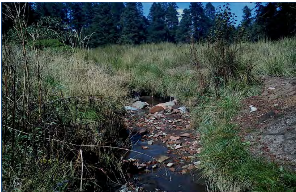
Figura IV-2.-Canal a Cielo Abierto de los Apapaxtles. Fuente: propia
