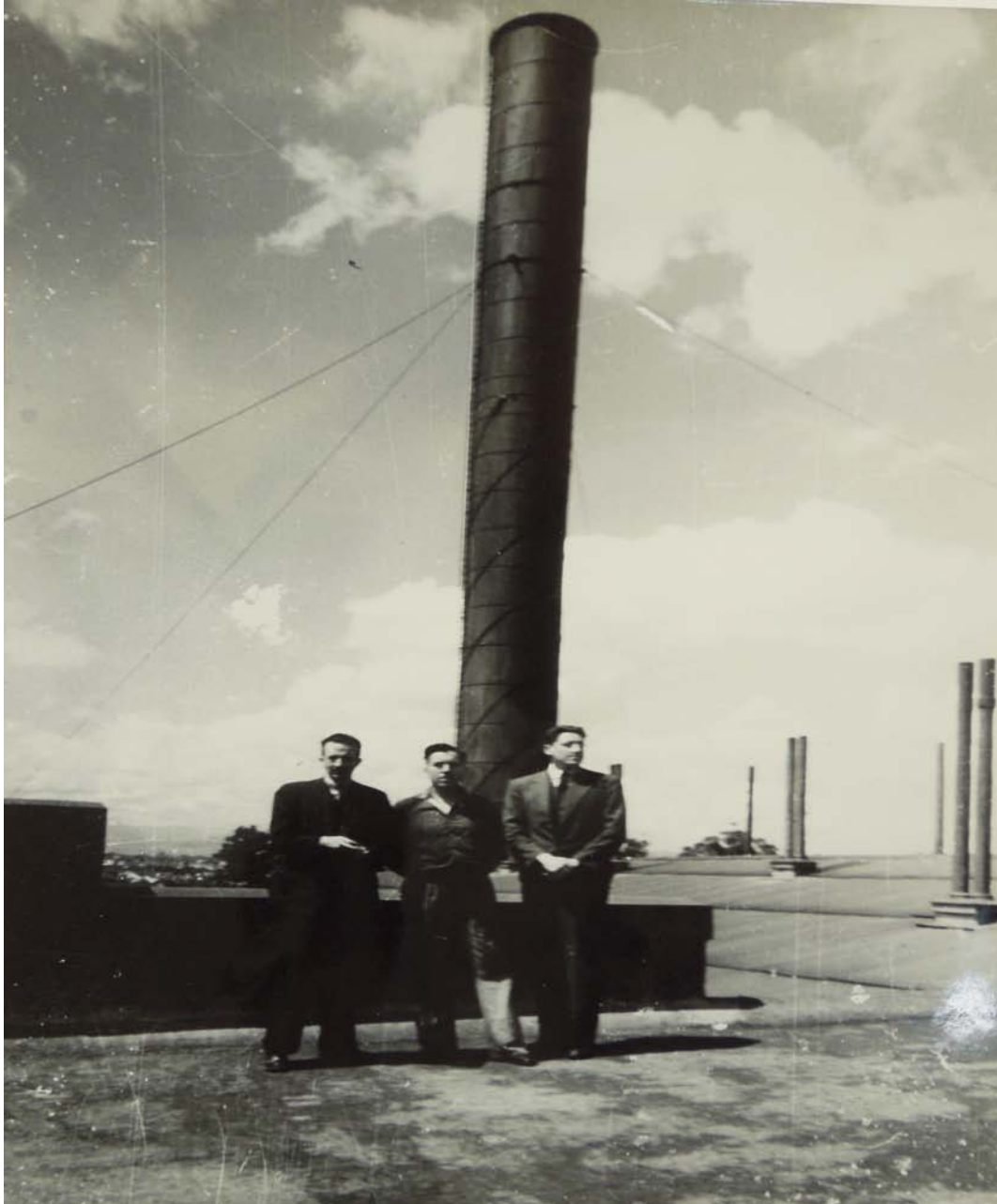
Central Hidroeléctrica de Nonoalco ( cod. 1.1.4, sig. 18/16.12, fotografías diversas, Archivo Josep Renau, IVAM)
