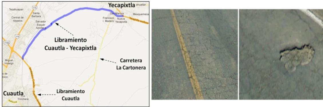
**Ilustración 4.1-4** Condiciones de la carpeta de rodamiento del Libramiento de Cautla – Yecapixtla
