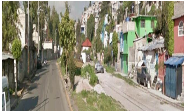
Figura # 4.26. Estado actual de la Línea N en Naucalpan.
