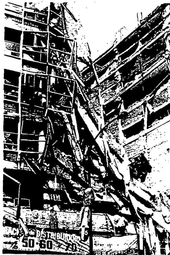
Foto 2 A - B Criterio 1: Derrumbe parcial o total de edificaciones.
