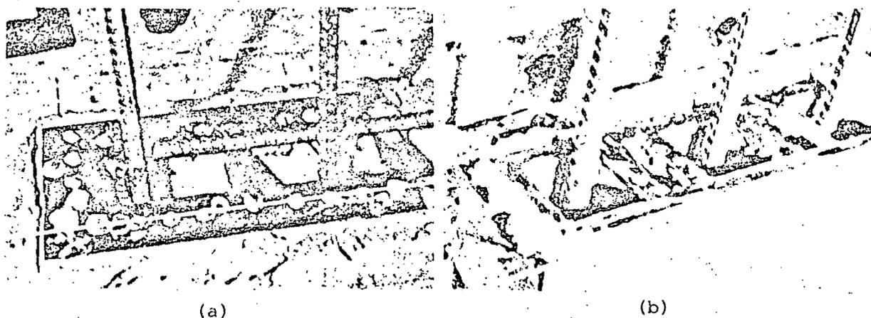
FIG. 5.12 Placas de confinamiento para muros de mampostería: (a) en mampostería con relleno de mortero reforzado, (b) en mampostería de piezas huecas reforzadas (9).
