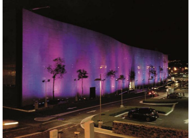
Palacio de Hierro, Centro Comercial Perisur
