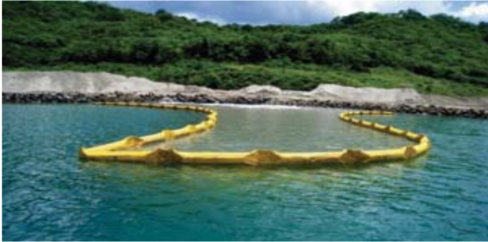
Figura 21. Cortina de contención de sedimentos
