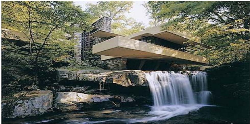
Figura 14. Casa de la Cascada. Frank Lloyd Wright
