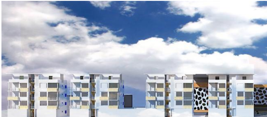
FACHADA PRINCIPAL UNIDAD DEPARTAMENTAL
