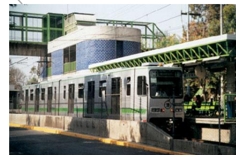
Tren Ligero, estación Xomali
