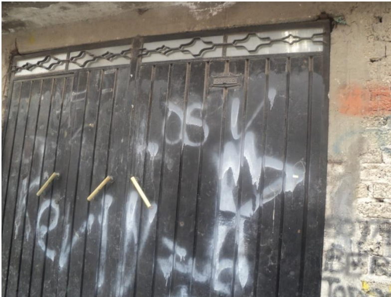
Fachada del terreno
