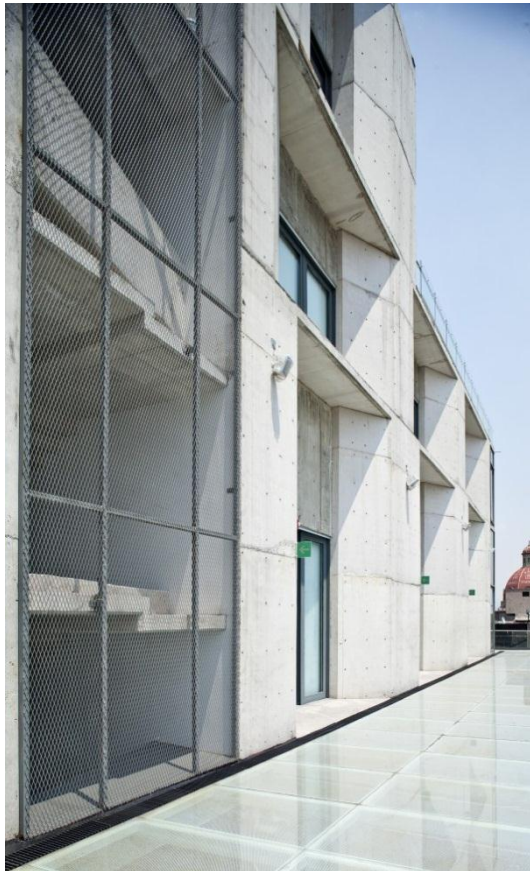
Vista de Escaleras
