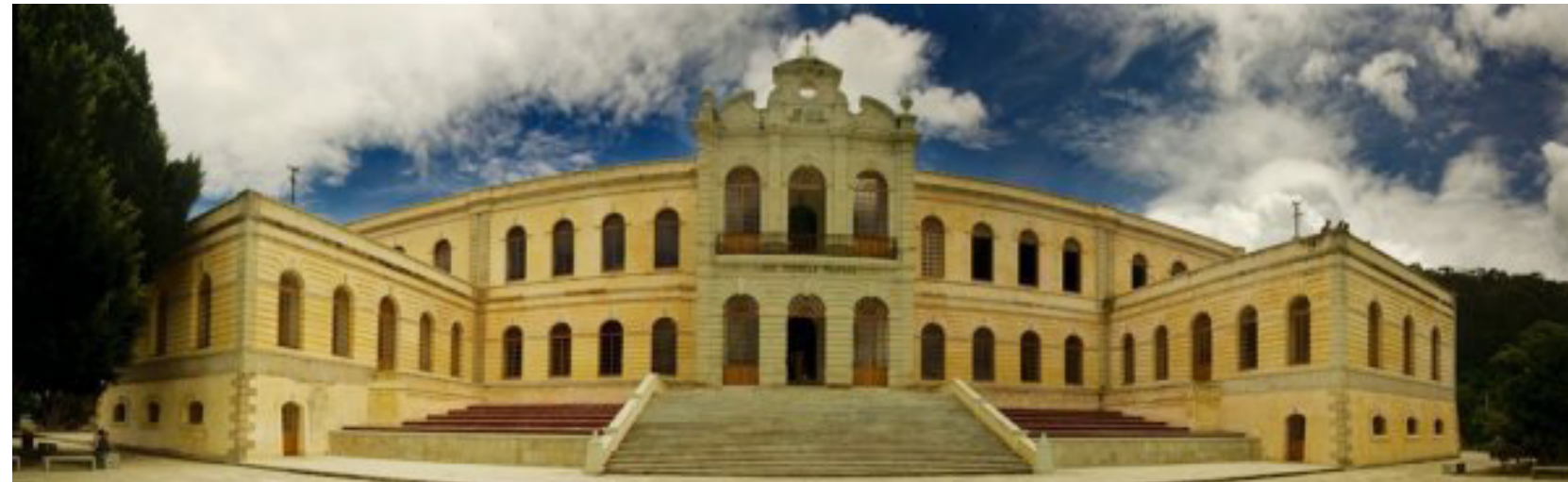
Fotografía de fachada, Ibíd.
