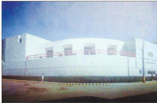
Foto 1. Fachada principal de casa hogar para ancianos "Los Tamayo".
