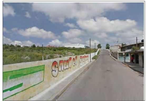
Foto 2. Circulación doble sentido.
