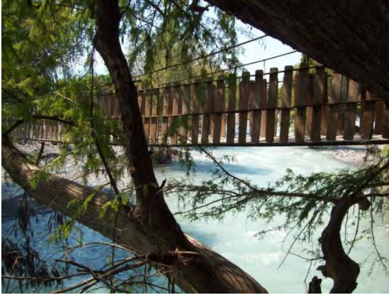
Figura 3.19. Municipio de Hualahuises: antiguo puente colgante
