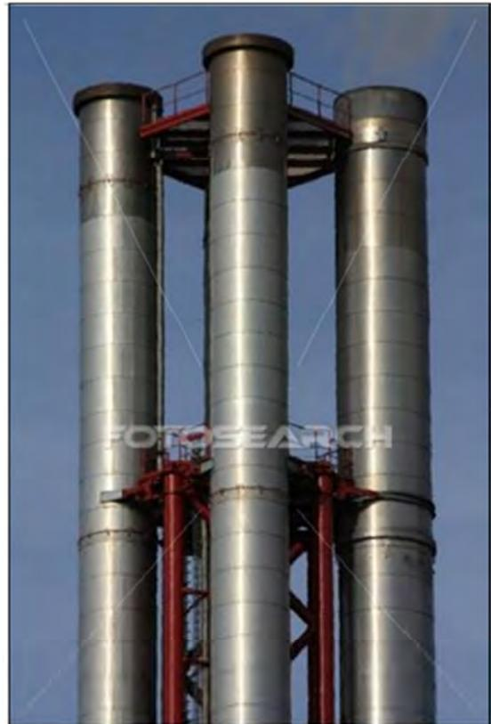
Fotografía 2.3 Chimenea con tiros independientes de la estructura. Fuente: FOTORESEARCH
