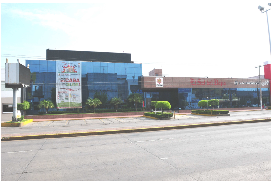
Fachada actual de las instalaciones de El Sol del Bajío, en el 1019 del Boulevard "Lic. Adolfo López Mateos".
