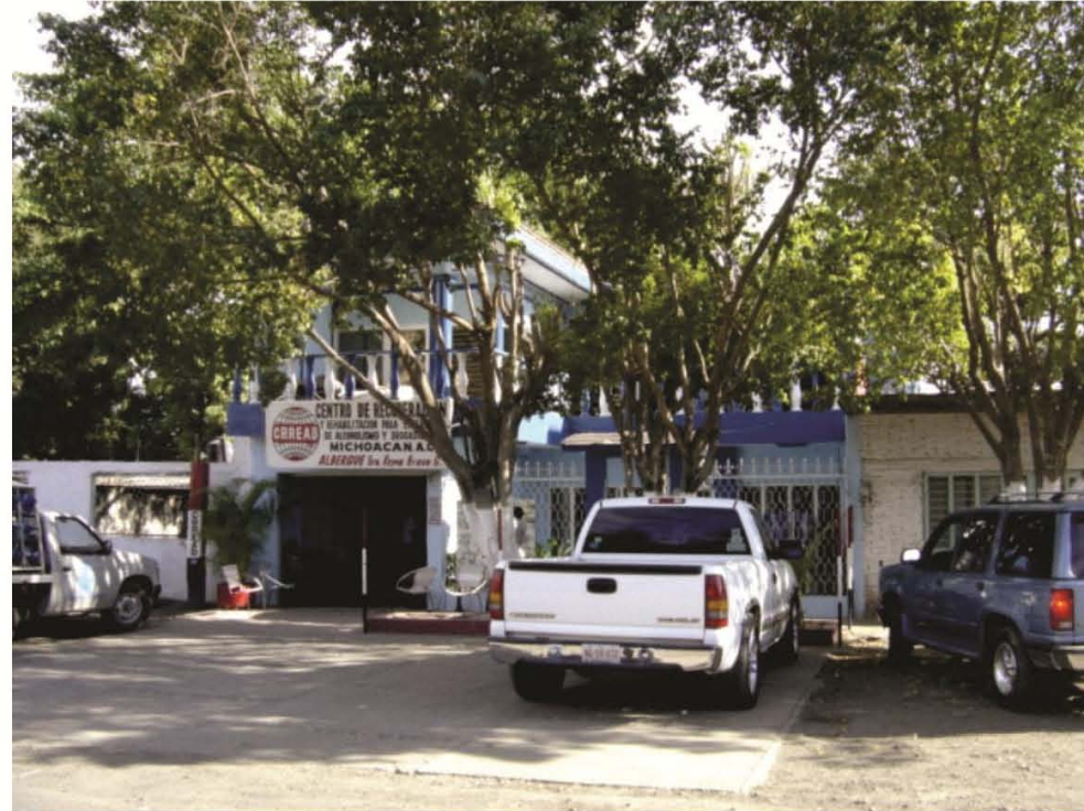
Vista general fachada
