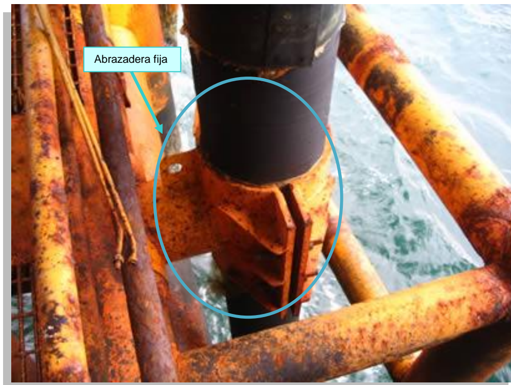
Figura 4. Abrazadera de ducto ascendente.
