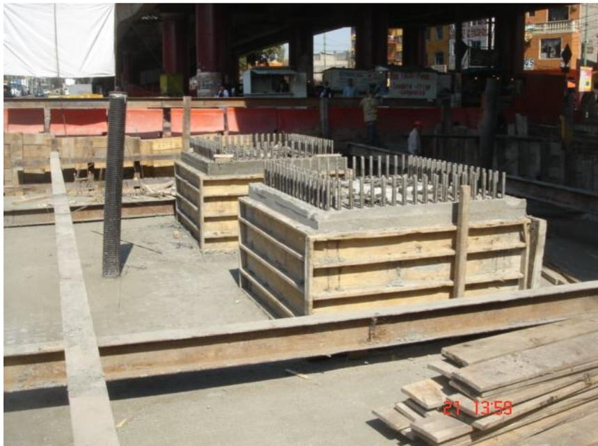
Imagen 19. Recubrimiento de placa de base
