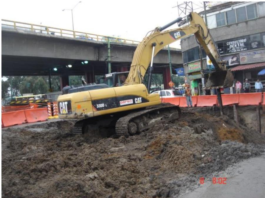
Excavación e hincado de viguetas verticales
