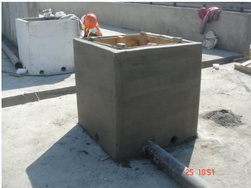
**Imagen 49. Caja registro para bajada de agua pluvial**
