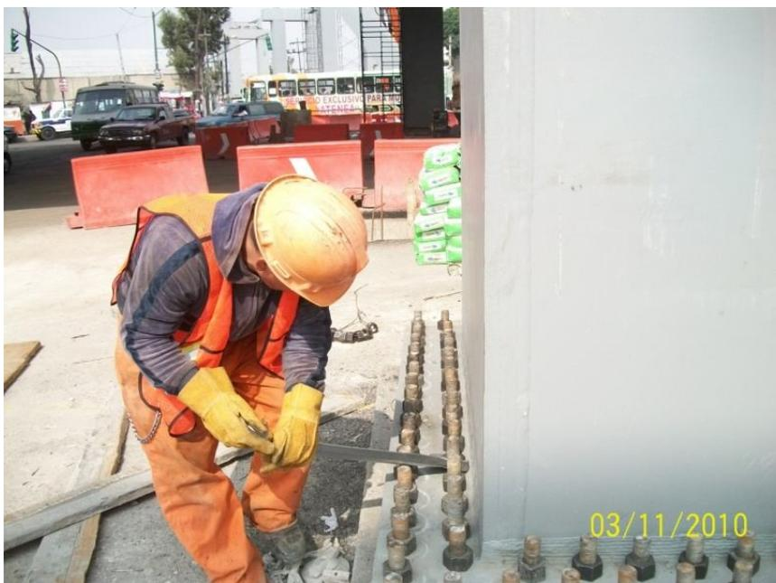
Imagen 24. Colocación de tuercas hexagonales tipo pesado
