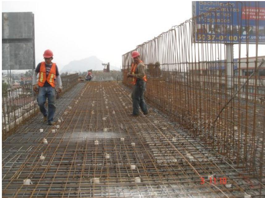
Imagen 42. Armado de losa de compresión
