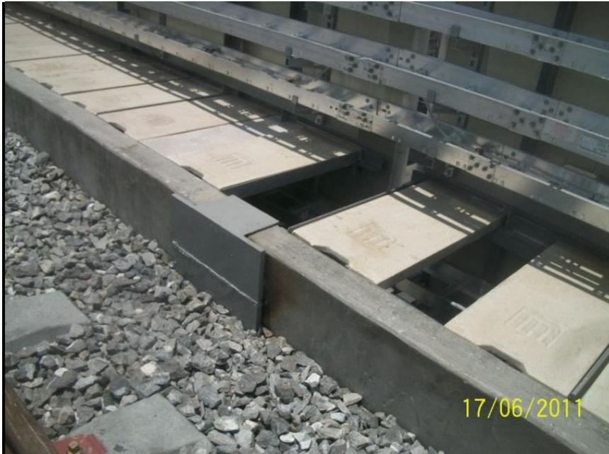
**Imagen 60. Tabletillas de policoncreto para andador de trinchera**
