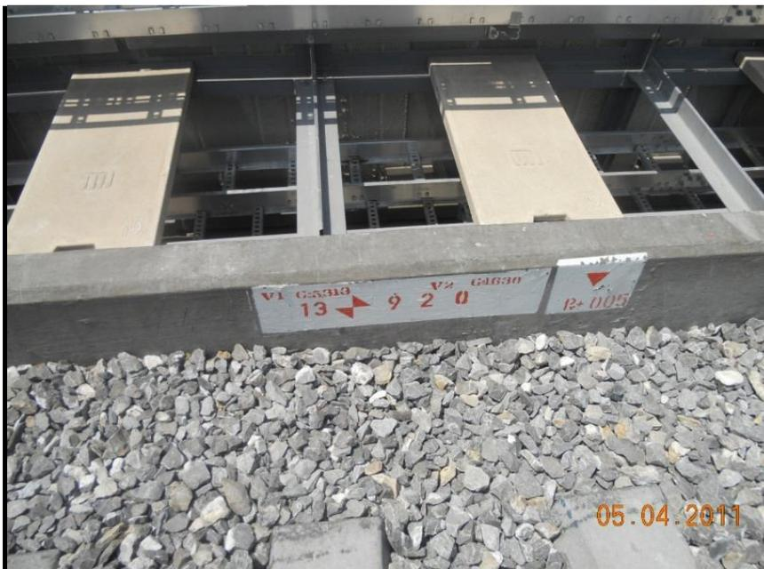
**Imagen 61. Perfiles para apoyo de tabletas de policoncreto**
