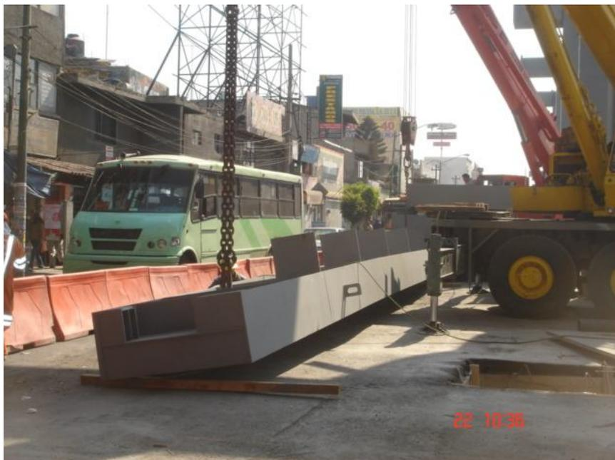
**Imagen 31. Colocación de travesaños metálicos en obra**
