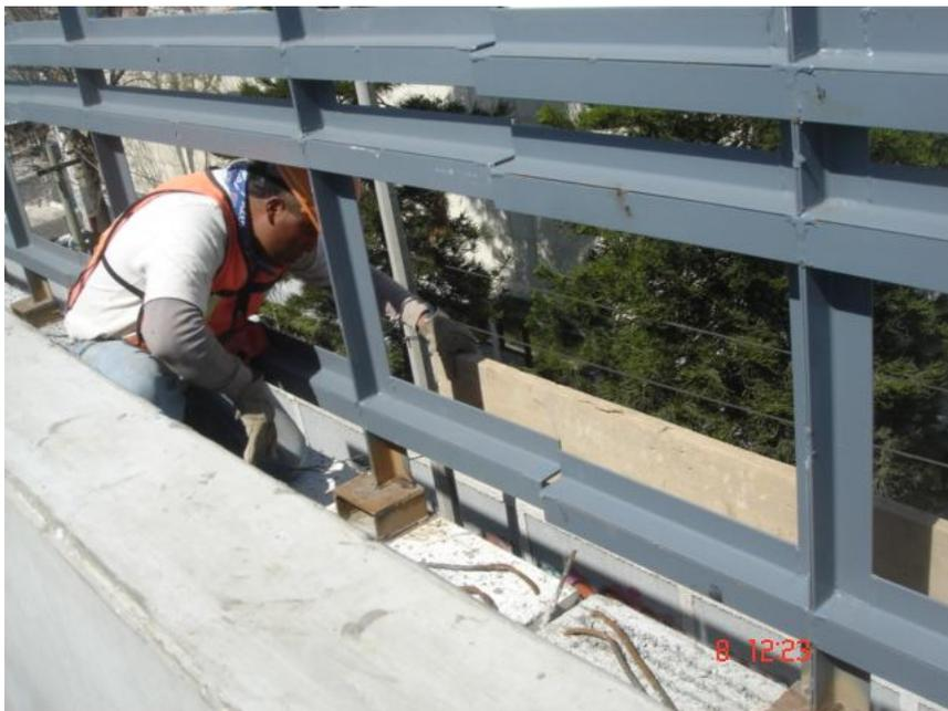
Imagen 57. Calzas para estructura de trinchera
