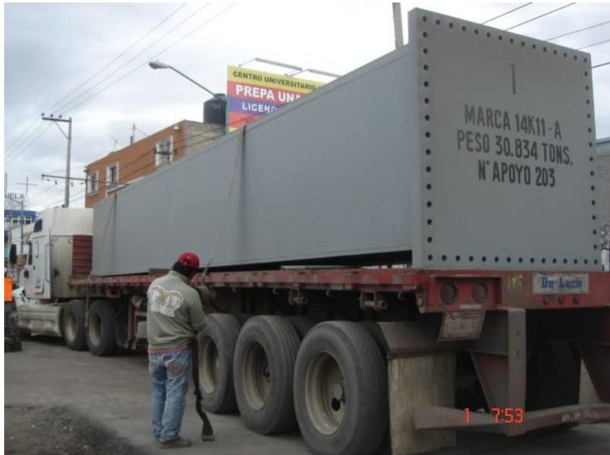
**Imagen 20. Traslado de columnas metálicas**
