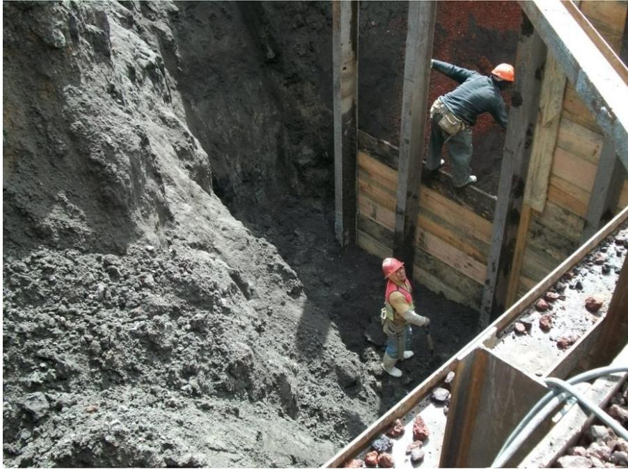
Colocación de tablonc de madera para sistema de retención
