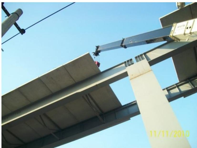
Imagen 40. Montaje de tabletillas precoladas
