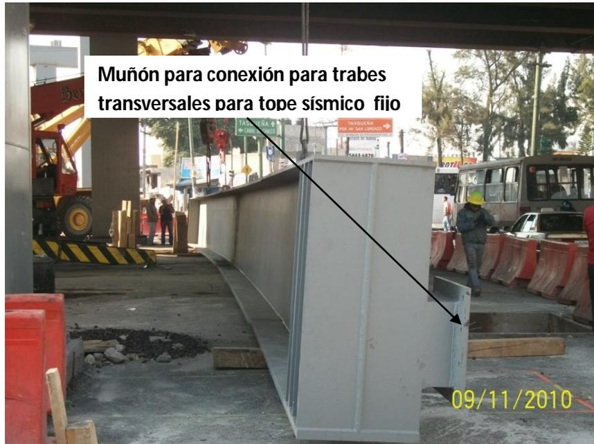
Una vez que se realiza la unión de las dos traves metálicas de 27.305 m que conforman este cruce, se colocan las traves sobre una cama de vigas metálicas previamente niveladas y se procede a dar el dimensionamiento de la posición de cada trabe a nivel de piso (Imagen 35).
