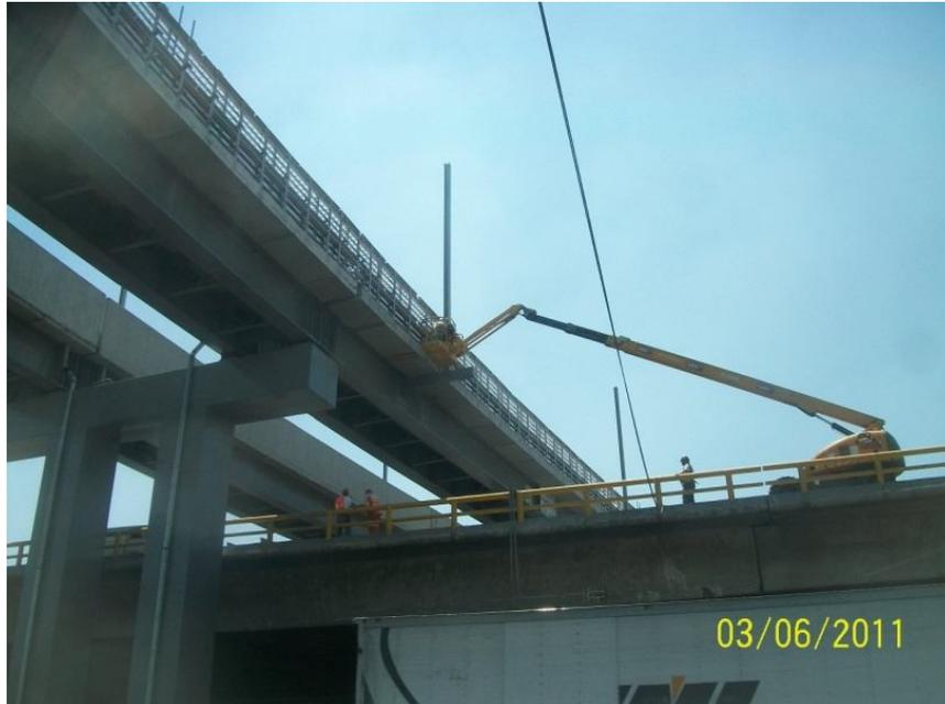
**Imagen 64. Colocación postes para catenarias**
