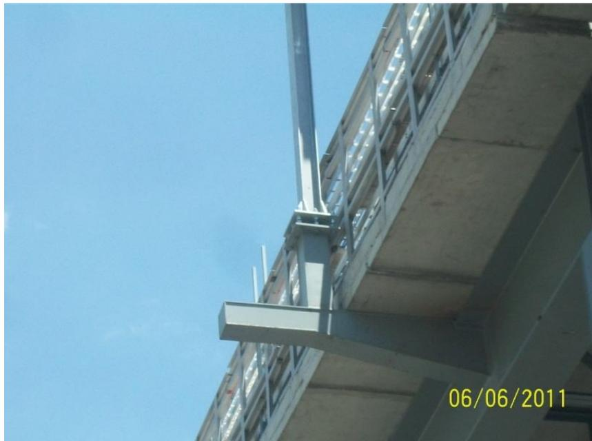
**Imagen 65. Detalle bases para catenarias**
