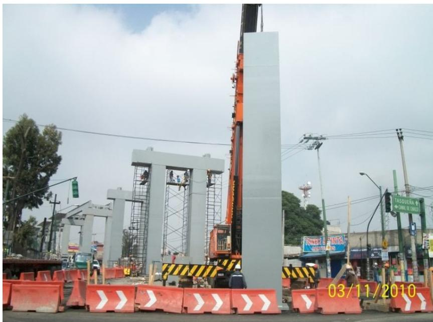
Imagen 22. Montaje de columna metálica con grúa móvil
