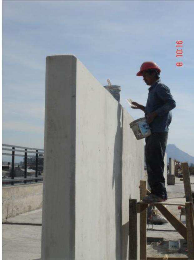
**Imagen 48. Aparentado de muros**
