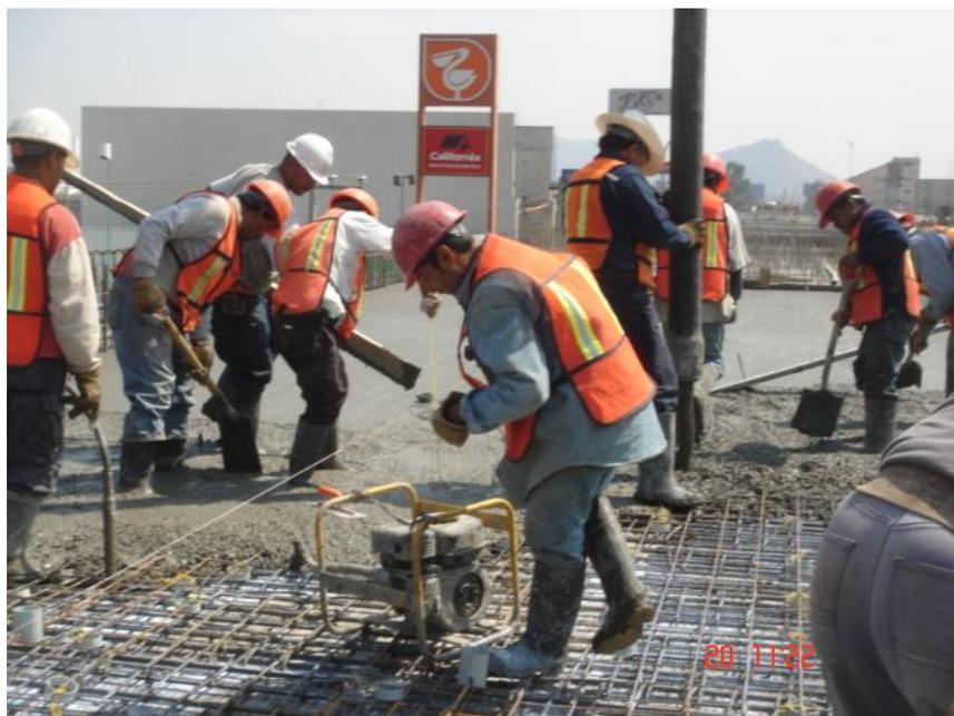
Imagen 43. Colado de losa de compresión
