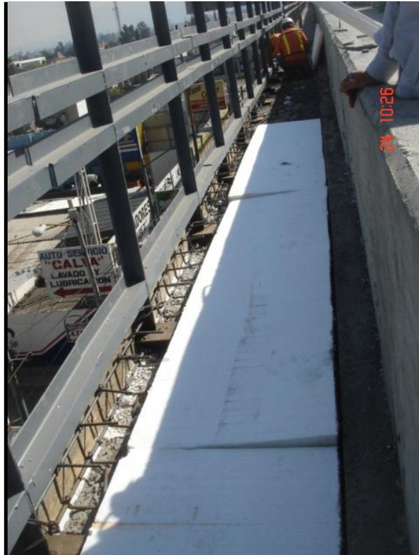
**Imagen 58. Relleno de poliestireno en trinchera**
