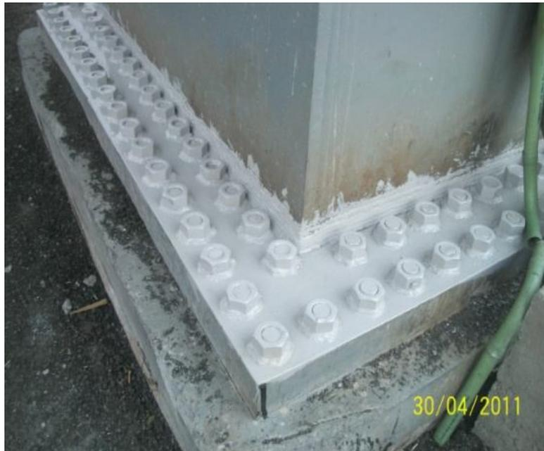
Imagen 26. Aplicación de pintura en base de columna
