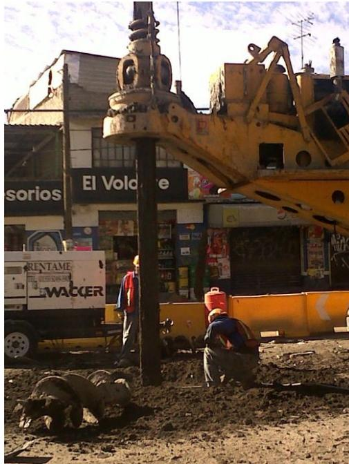
Imagen 5. Perforación previa con broca helicoidal
