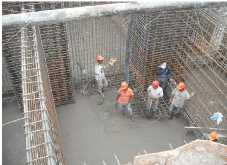
Imagen 11. Colado de losa de fondo y porción de 50 cm de muros perimetrales
