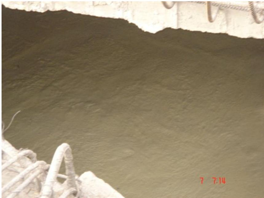
**Imagen 16. Sistema de impermeabilización a base de espuma de poliuretano**
