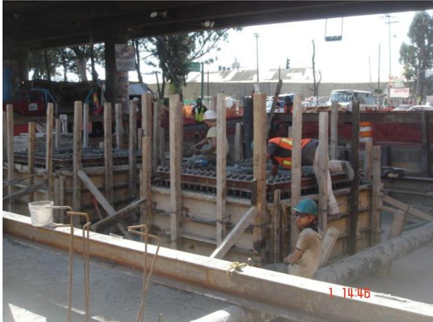
Imagen 18. Colado de ajuste de dados, colocación de tuercas de nivelación y placa de base
