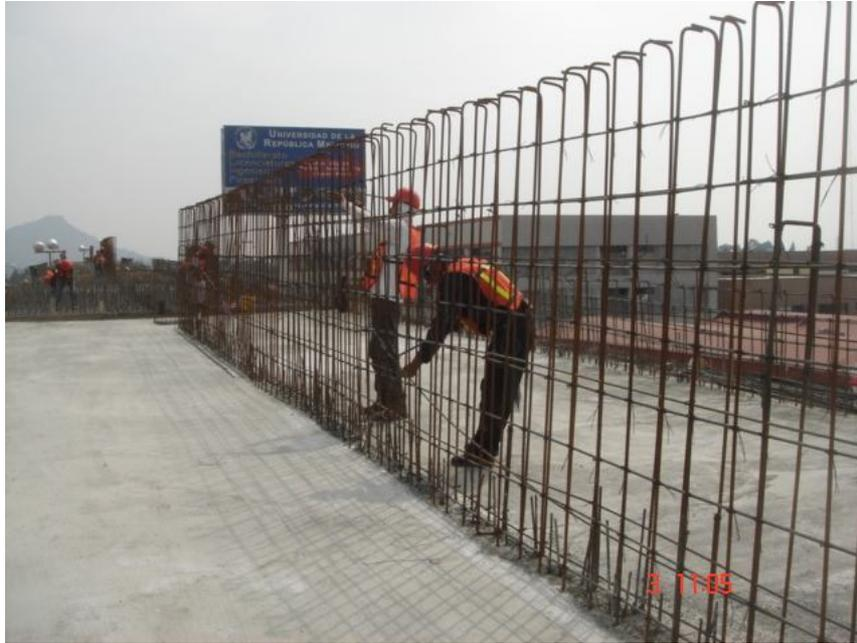
**Imagen 46. Armado de muro central**
