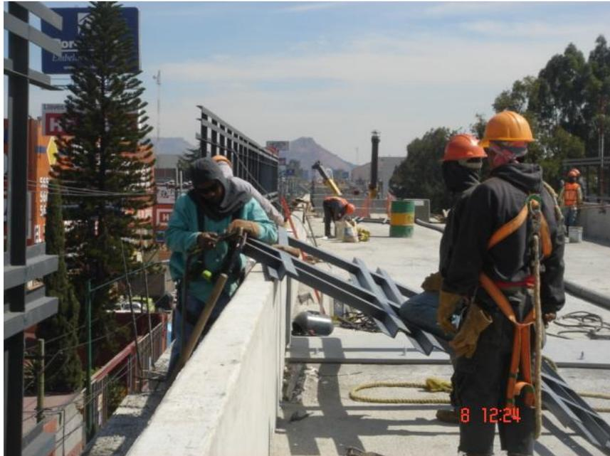
Imagen 56. Colocación de bastidores metálicos
