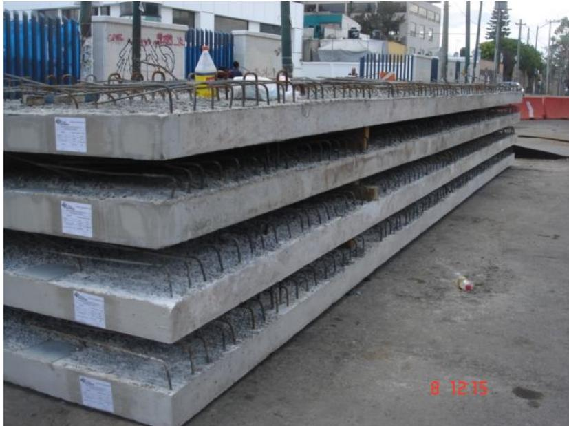
Imagen 39. Tabletillas prefabricadas para zona de vía
