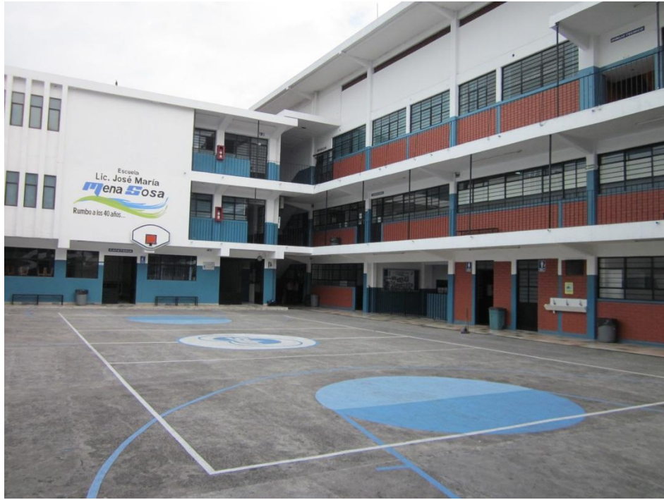
Figura 2. Fotografía interna de la Escuela Secundaria y de Bachilleres Lic. José María Mena Sosa.
