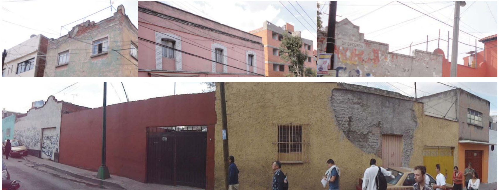
Remates y Cornisas. Levantamiento en sitio.
