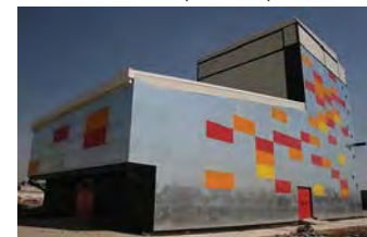
4 SURORIENTE SALIDA DE EMERGENCIA+ACCESO 3
