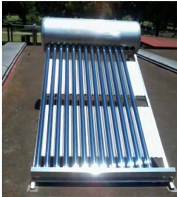
Figura 4.8 Imagen del Concentrador Solar de Tubos Evacuados de la Facultad de Ingeniería.
