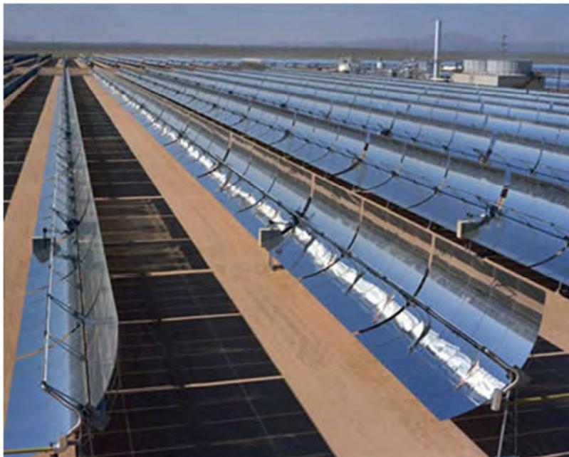
Figura 1.6 Colector solar de canal parabólico. [1.19]
