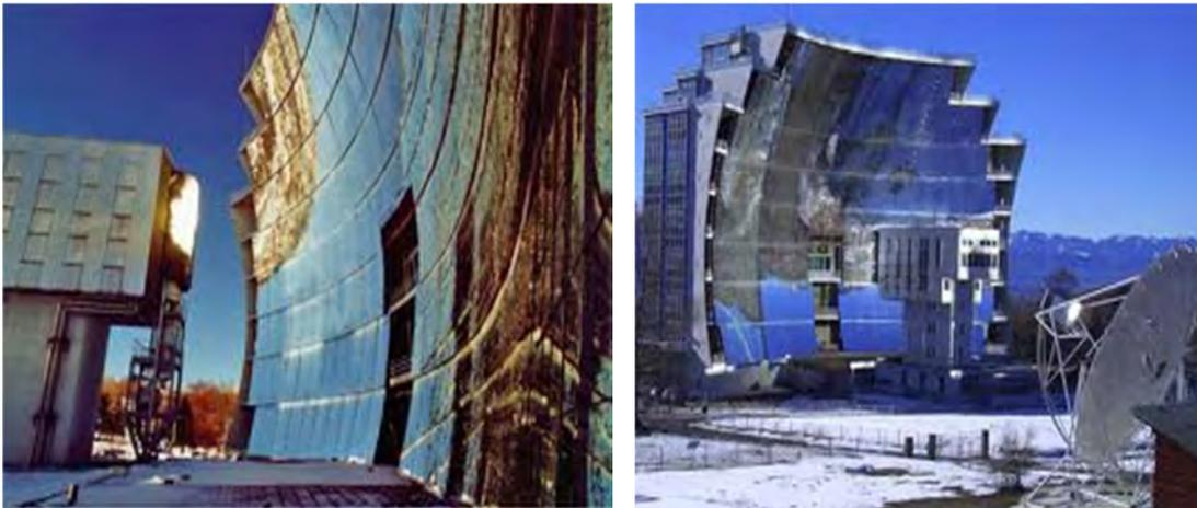
Figura 2.14 Horno solar constituido de 63 paneles solares.
