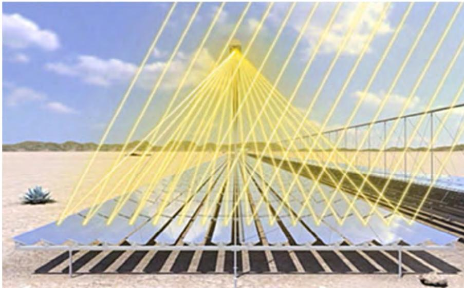
Figura 1.15 Funcionamiento de los colectores Fresnel. [1.18]
