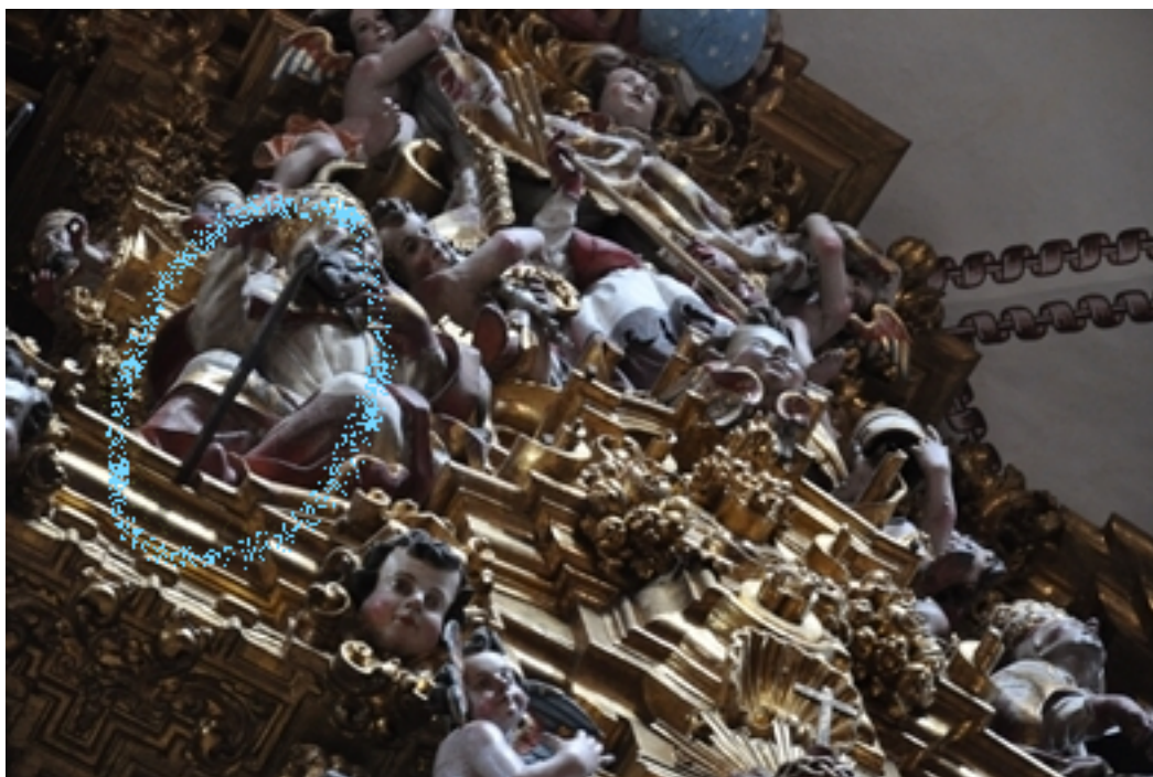
30. Uno de los seis soportes metálicos en la cornisa del entablamento. Foto LA. 2010. ENCRyM-INAH.
