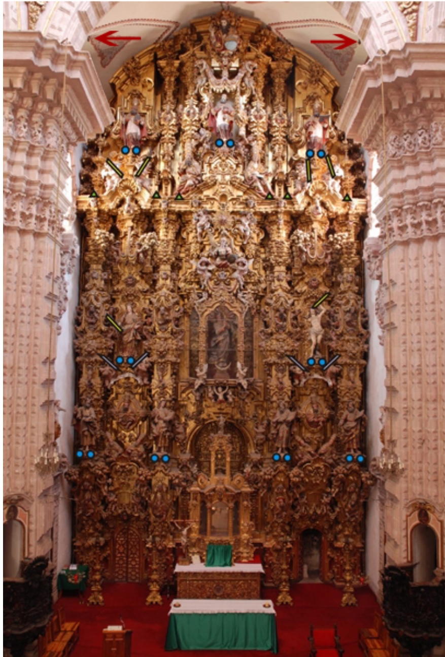
26. Vista general del retablo de la Inmaculada Concepción. Candeleros originales (círculos azules), palmas corladas (líneas coloreadas) y soportes metálicos, (triángulos verdes). En el intradós de la bóveda se aprecian las poleas para mover una cortina de retablo (señalados por flechas rojas). Foto JAJ. 2007. ENCRyM-INAH. Marcado de FU. 2010.
