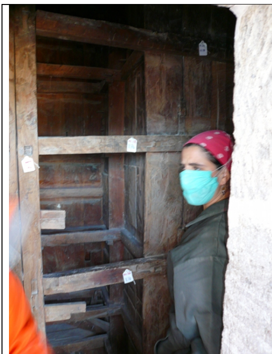
13. Armazón del retablo visto desde la plataforma interior a unos 15m de altura. Se aprecia su profundidad que llega a tener hasta 1.5m en algunas zonas. Foto AC, 2007.
