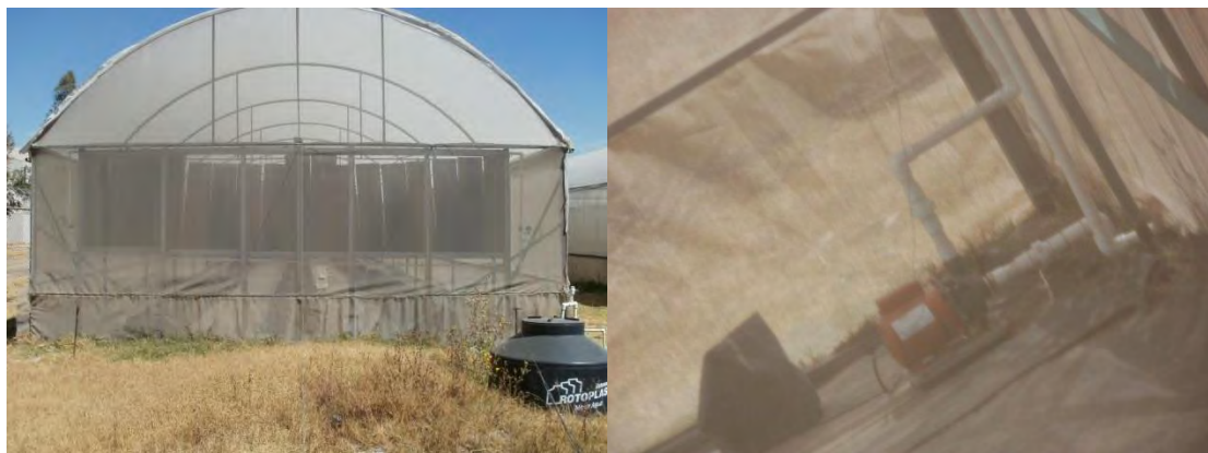
Figura 2.4 Vista de pared húmeda, tanque de agua y bomba de riego
