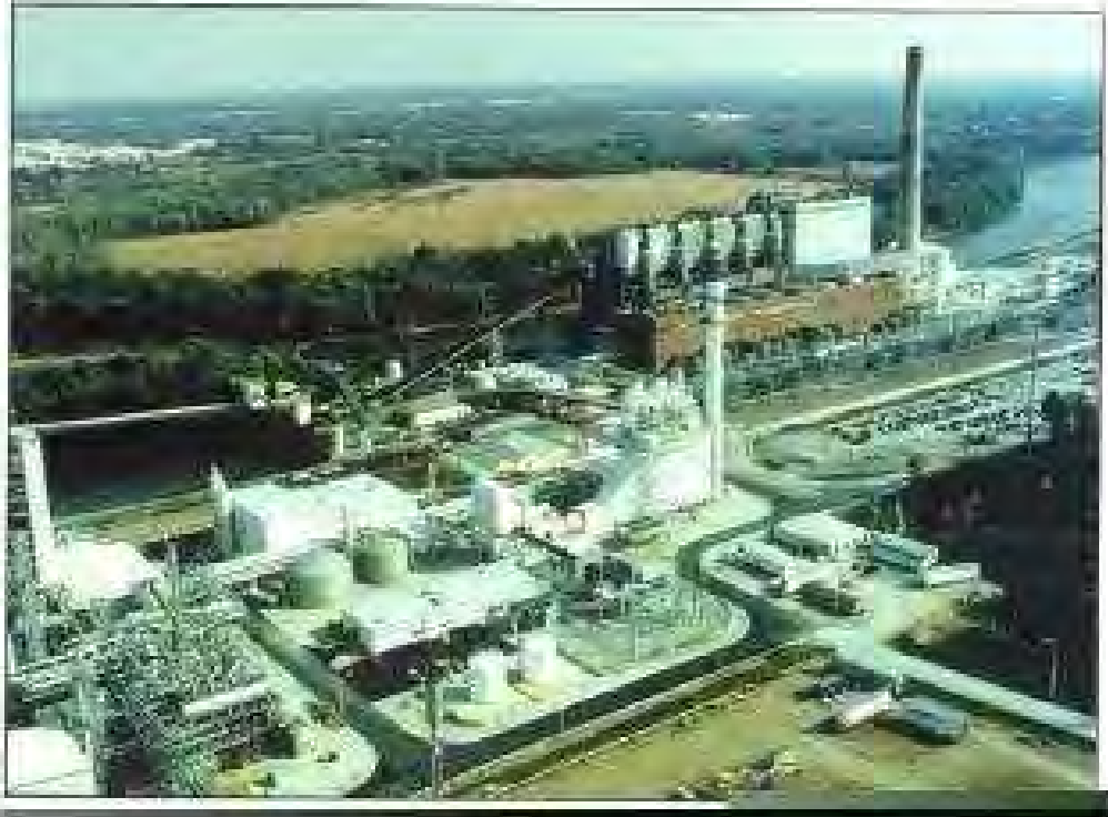
Figura 42. Planta piloto de Gasificación de Vapor
