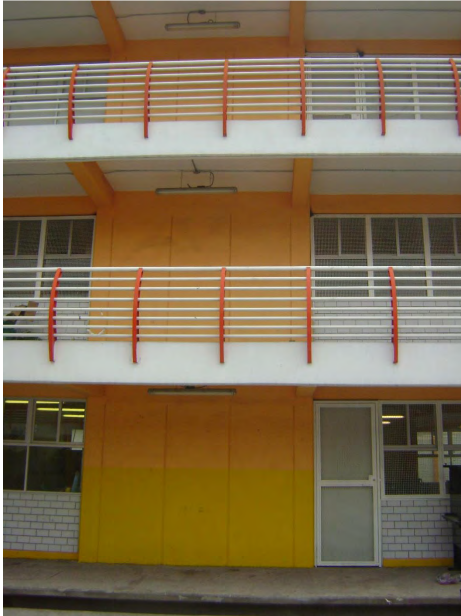
Figura 5.1: Detalle de los aleros en la fachada Sur.
