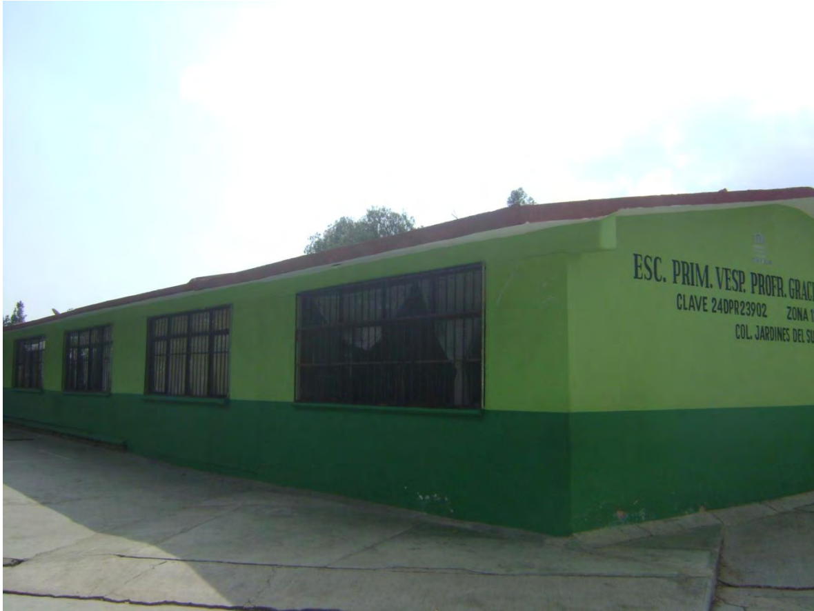
Figura 5.6: Fachada Sur del edificio.
