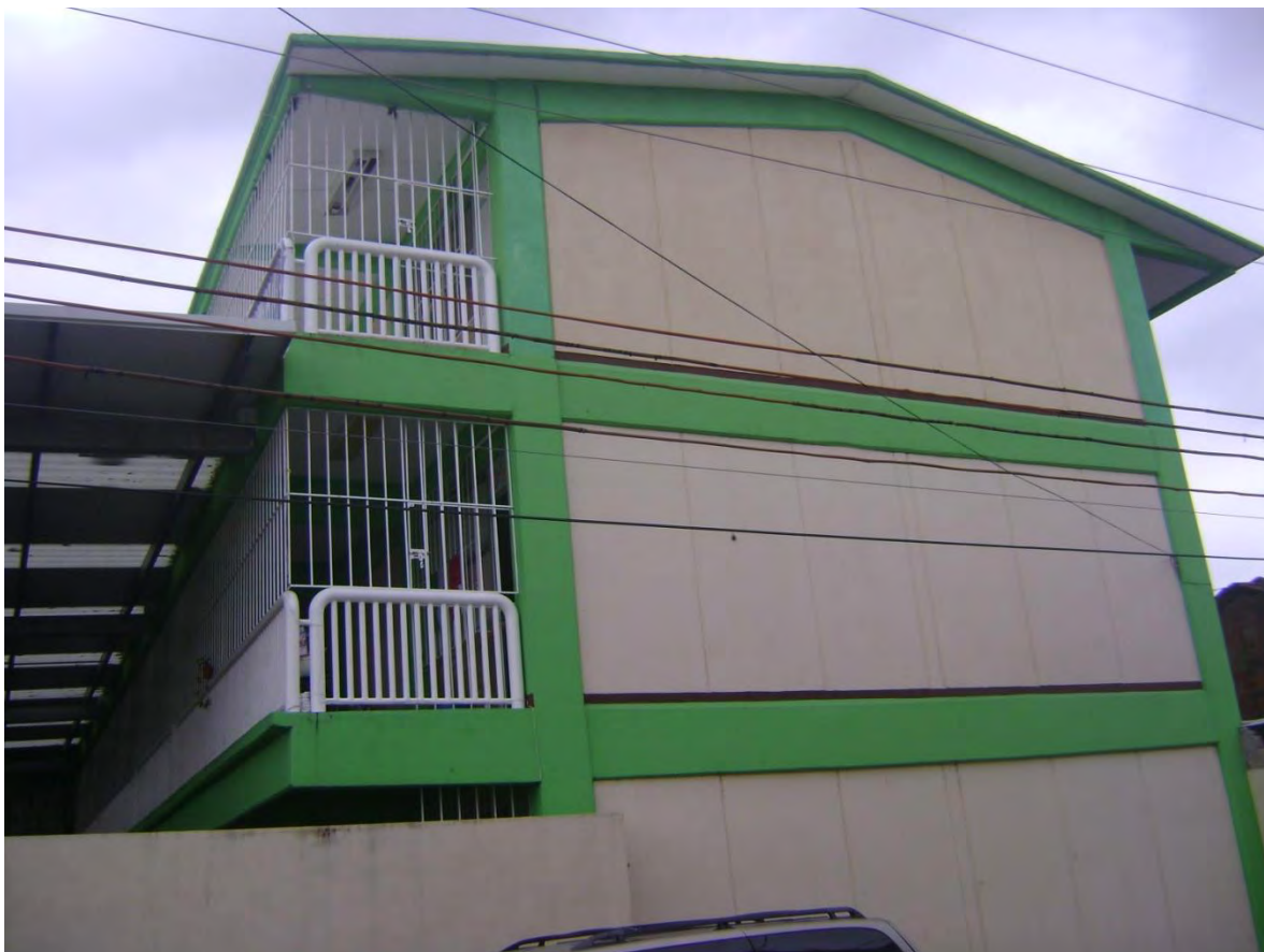
Figura 5.8: Detalle de los aleros en las fachadas Este y Oeste.
