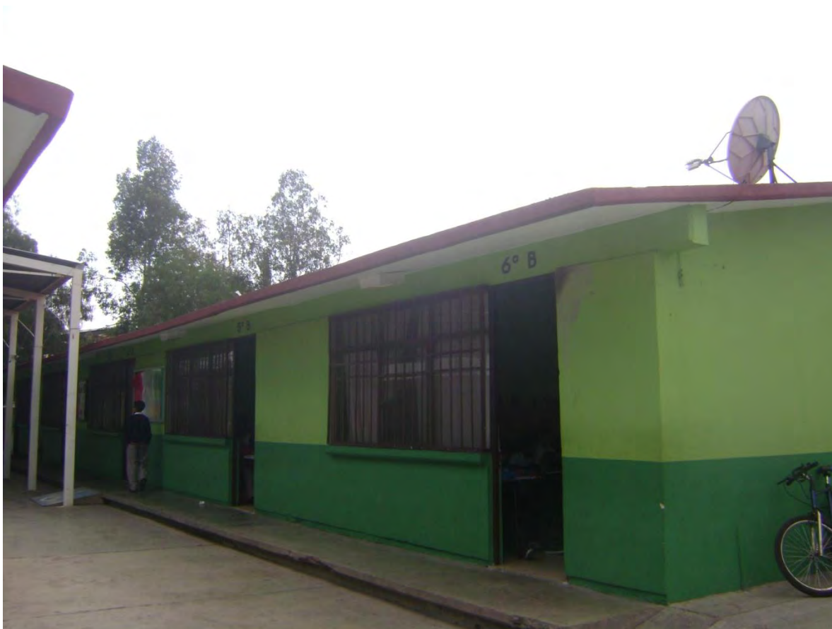
Figura 5.5: Fachada Norte del edificio.
