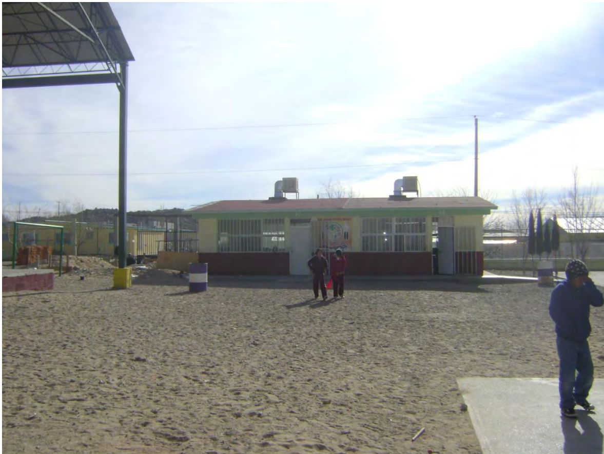
Figura 5.10: Edificio 1, vista de la fachada Norte.
