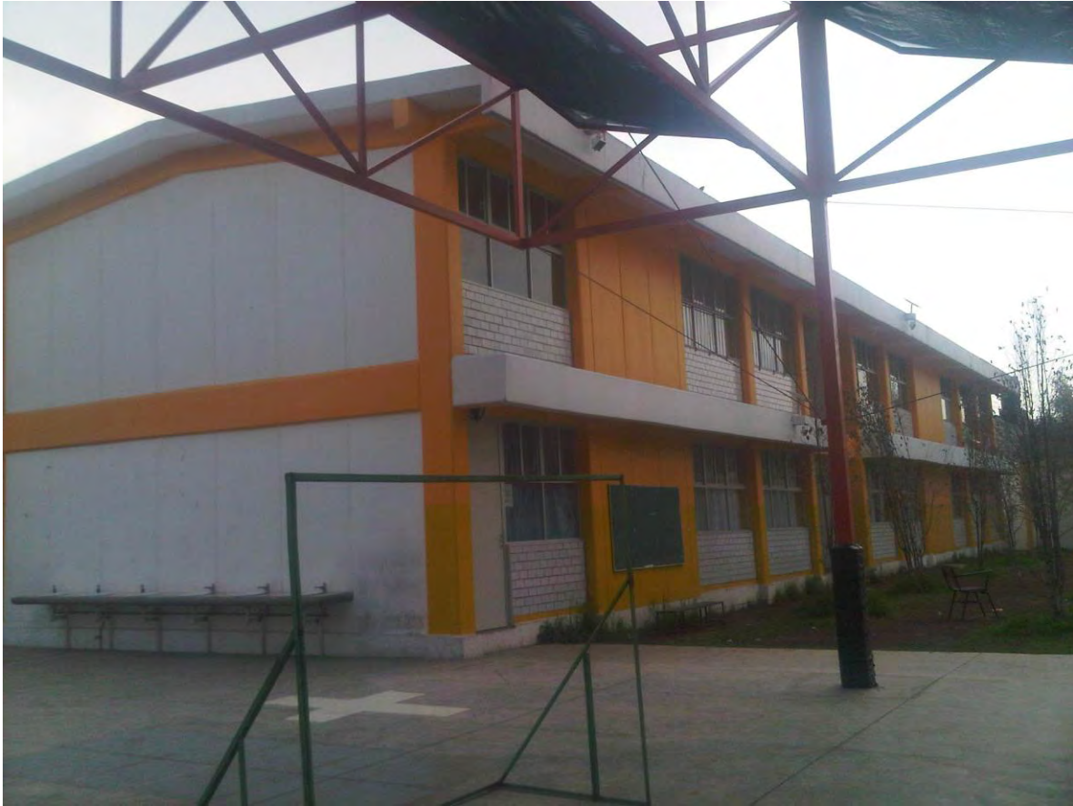
Figura 5.4: Fachada Sur del Edificio 2.
