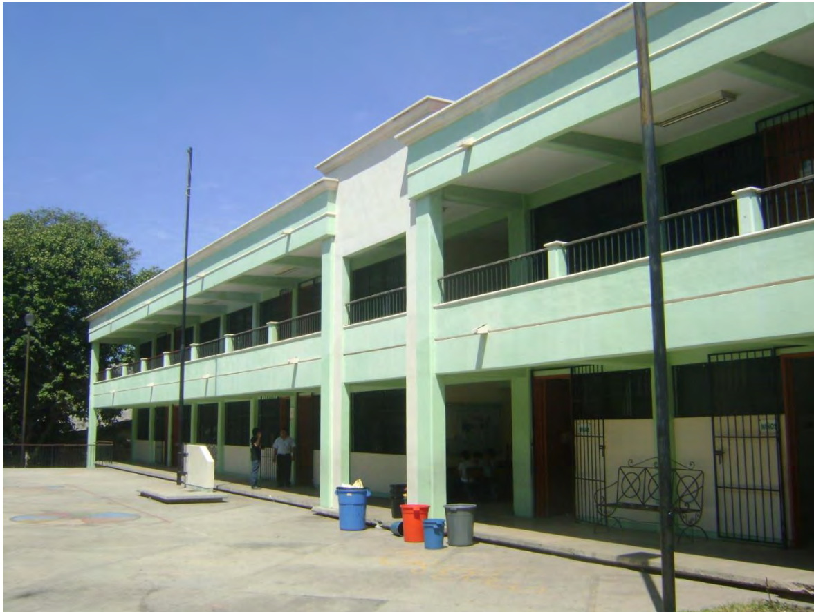
Figura 5.16: Fachada Sur del Edificio B.
