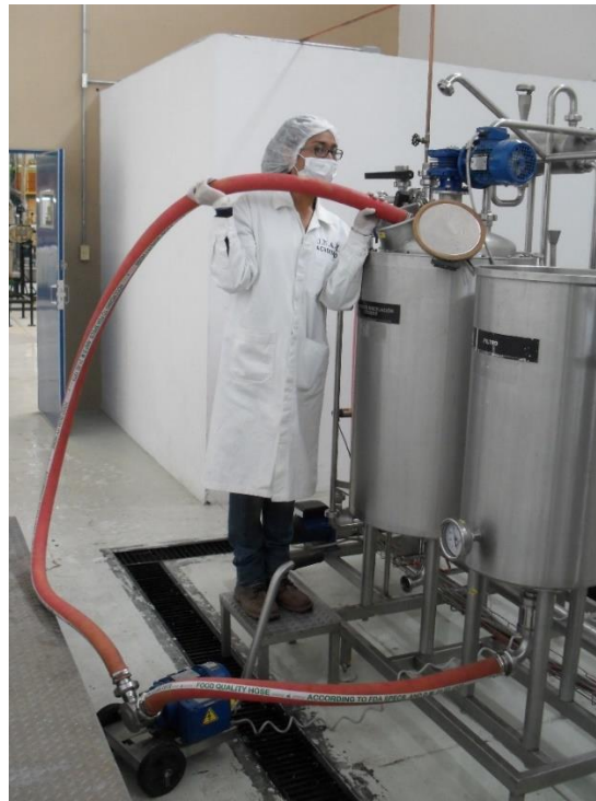
Figura 28. Personal transfiriendo el mosto desde el tanque SO3 al SO2.
