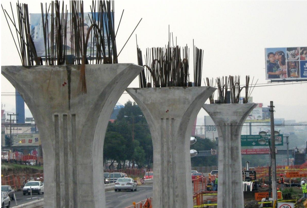
Figura 1.39 Columnas de concreto presforzado, sobre el Boulevard Manuel Ávila Camacho
