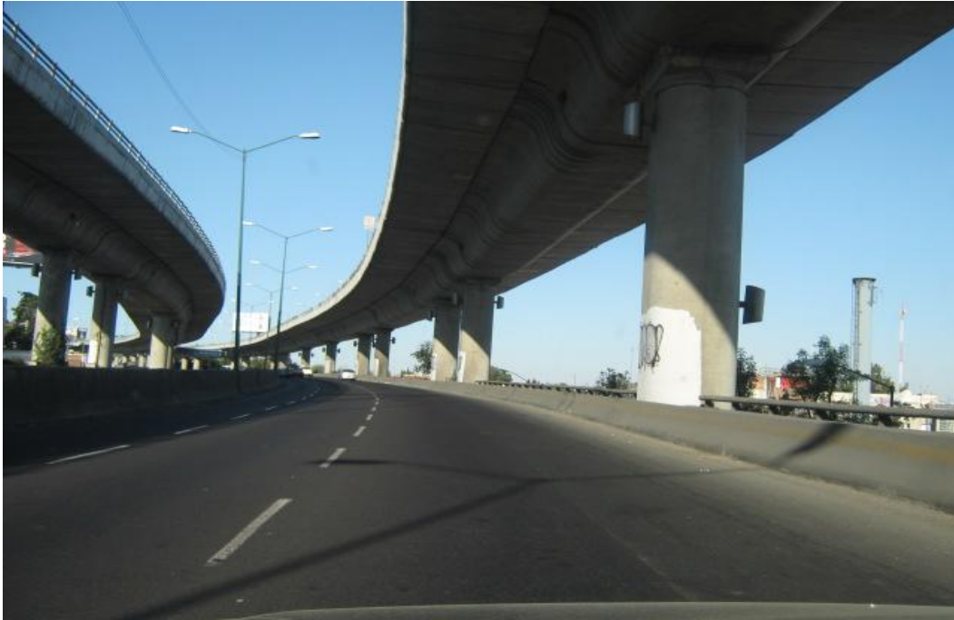
Figura 1.17 Columnas presforzadas soportando traves principales
