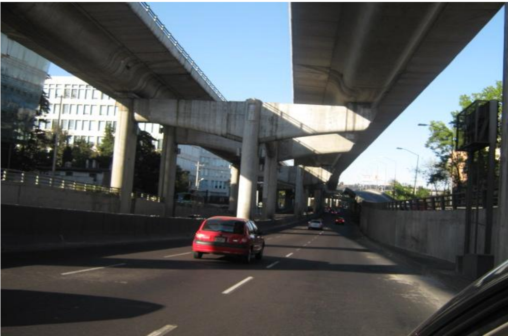
Figura 1.13 Columnas presforzadas soportando traves principales
