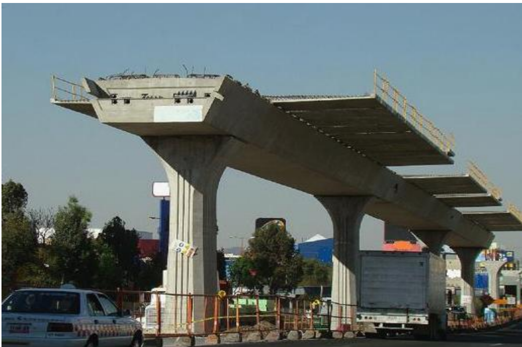
Figura 1.42 Columnas presforzadas soportando trabe principal
