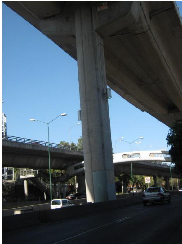
Figura 1.18 Columnas presforzadas soportando traves principales
