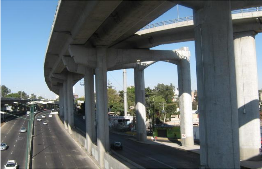
Figura 1.13 Columnas presforzadas soportando traves principales
