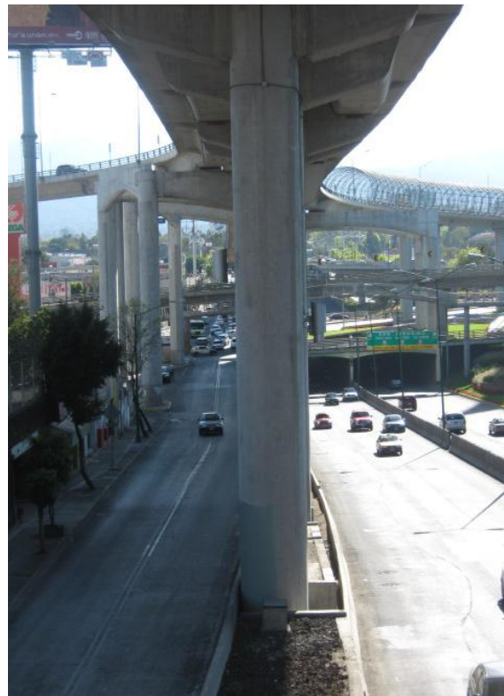
Figura 1.16 Columnas presforzadas soportando traves principales
