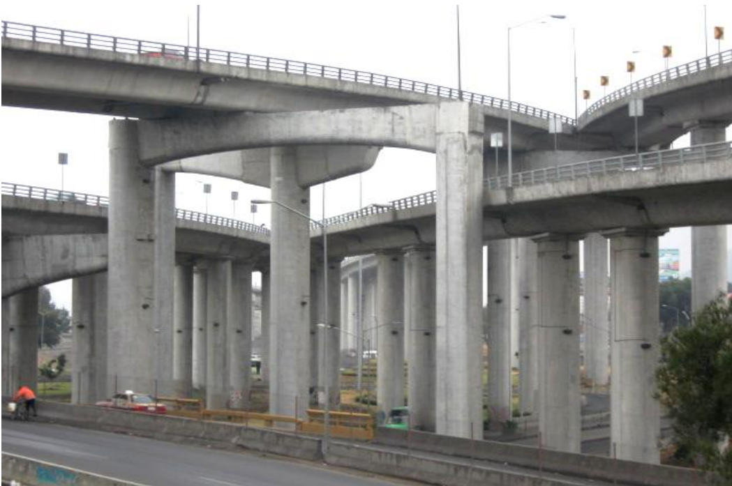
Figura 1.23 Columnas presforzadas soportando traves principales
