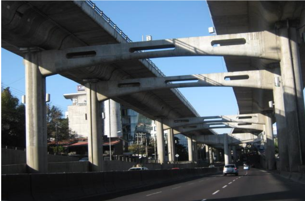
Figura 1.15 Marcos de rigidez a base de columnas y traves de concreto presforzado
