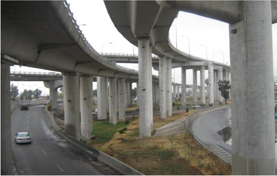
Figura 1.23 Columnas presforzadas soportando traves principales
