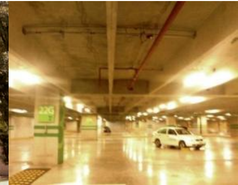
Imagen 35. Estacionamiento, Plaza Antara .
