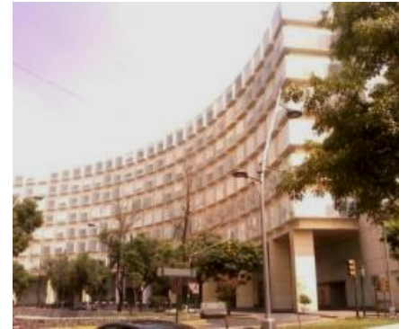
Imagen 34. Estacionamiento, Plaza Antara .
