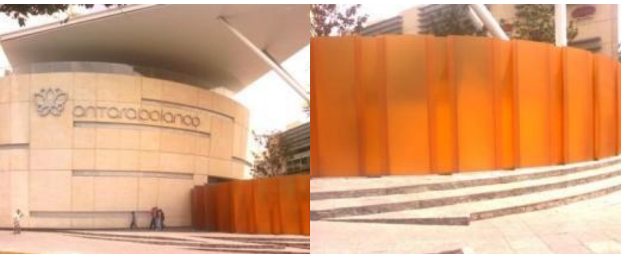
Imagen 36 . Diversas fachadas del Conjunto Antara Polanco.
