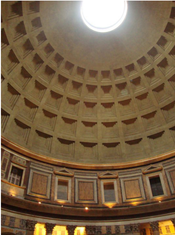
Imag. 51. Panteón de Roma. Una de las primeras construcciones de concreto sin refuerzo de acero
