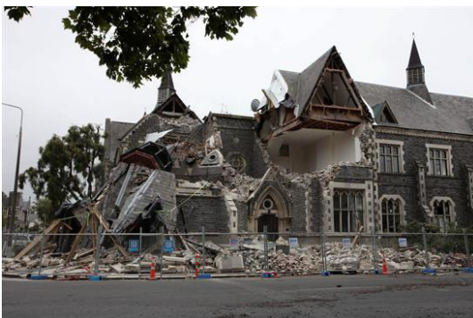
Imag. 10 Sismo en Nueva Zelanda 2011. Edificio en Christchurch
