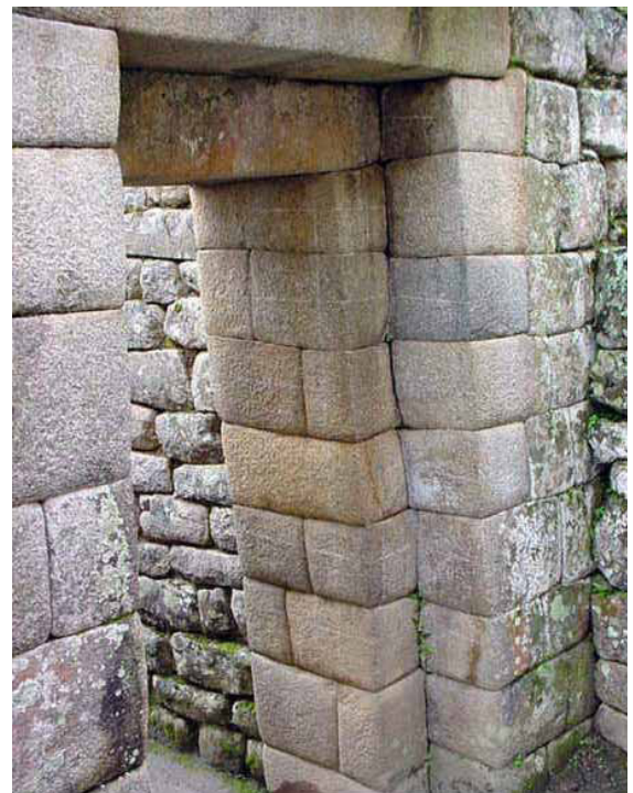
Imag. 35 Marco de los vanos de las construcciones de Machu Picchu
