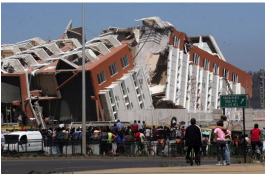
Imag. 8 Terremoto en Chile 2010. Edificio en Concepción
