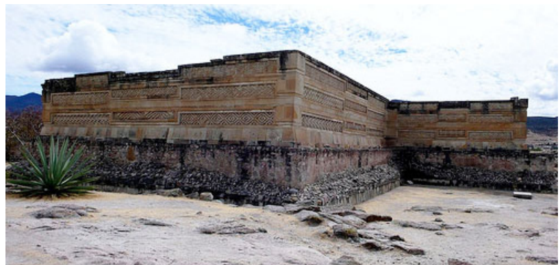
Imag. 33. Edificio en Mitla, donde se observa el uso de tableros escapulario, muros gruesos y baja altura.
