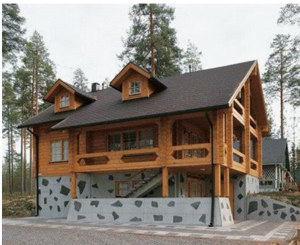
Imagen 58. Casa de madera con base de piedra que funciona como aislamiento
