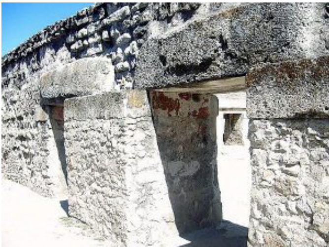
Imag. 30 Uso de dinteles en el Templo del Grupo de las Columnas, Mitla
