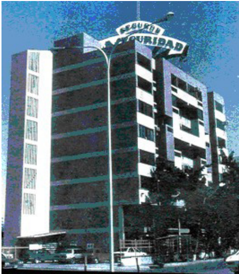
Imag. 92. Edificio Miramar antes del sismo. El anuncio espectacular que se encuentra en el techo era una carga no contemplada en el cálculo estructural, lo que provoca una distribución irregular de masa.
