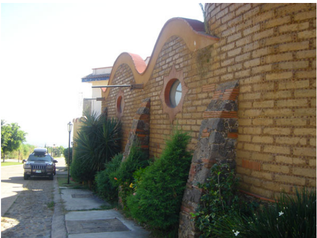
Imagen 68. Uso de contrafuertes en una casa de adobe en Cuernavaca, Morelos
