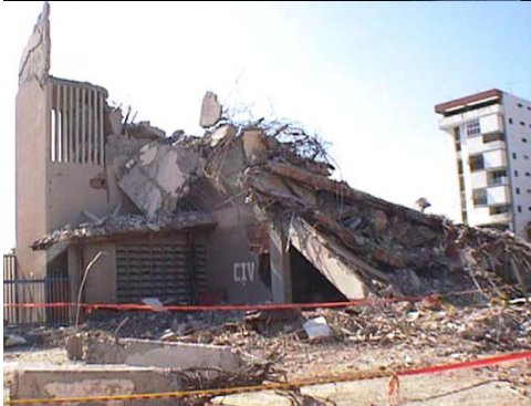
Imag. 93. Edificio Miramar después del sismo de 1997.
