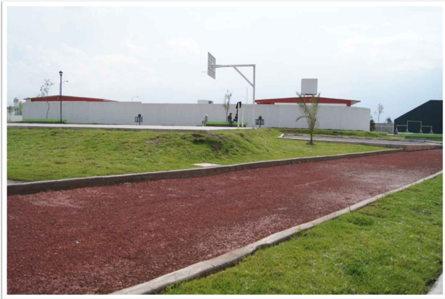
IMAGEN 6. Vista de Zona Deportiva y Fachada posterior del Jardín de niños.
