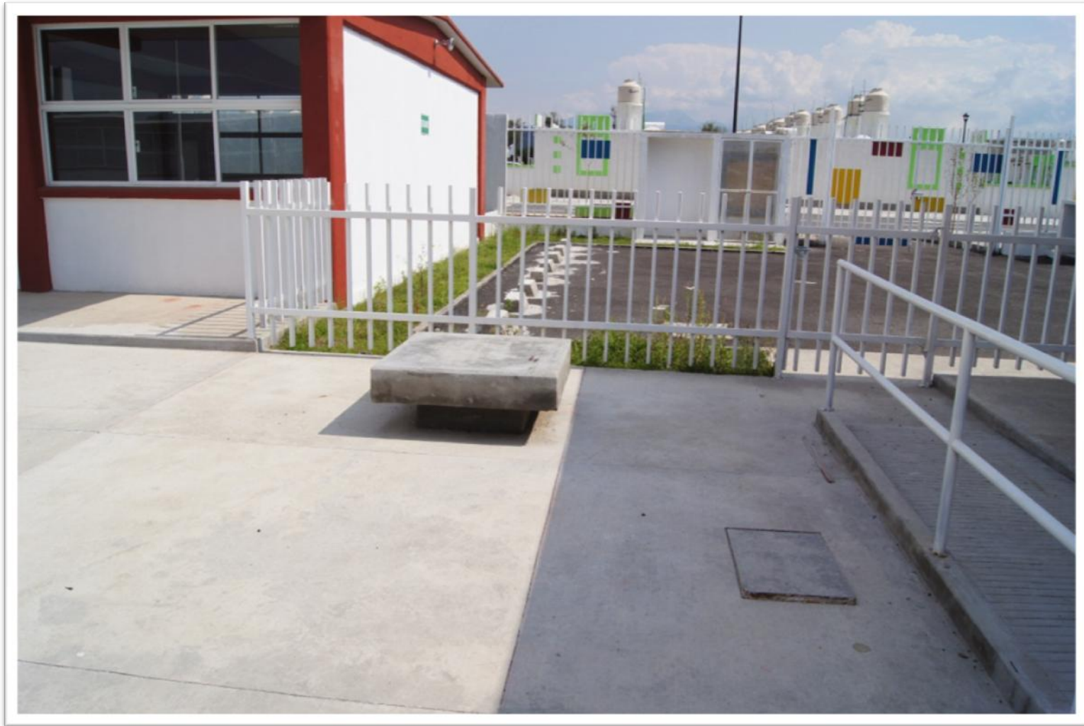
IMAGEN 14. Vista interior de la reja del estacionamiento del Jardín de niños.
