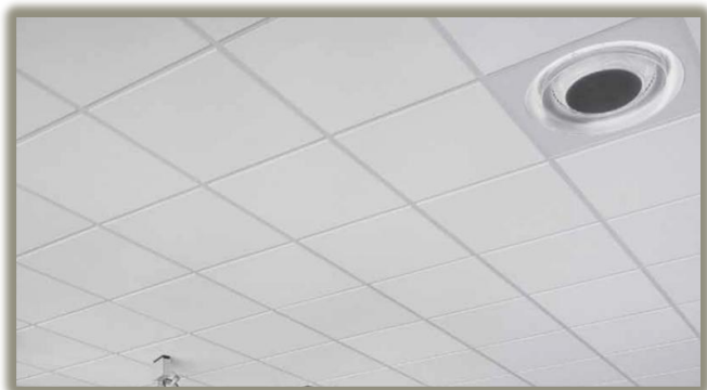
TECHO DE FIBINERAL US ARCE
