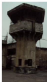
Torre de vigilancia (Estado Actual)
