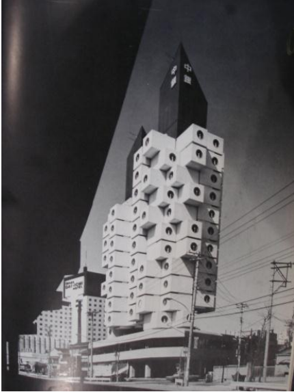
Imagen 14. Edificio de departamentos proyectado por Kurokawa. Foto: El lenguaje de la arquitectura posmoderna.
