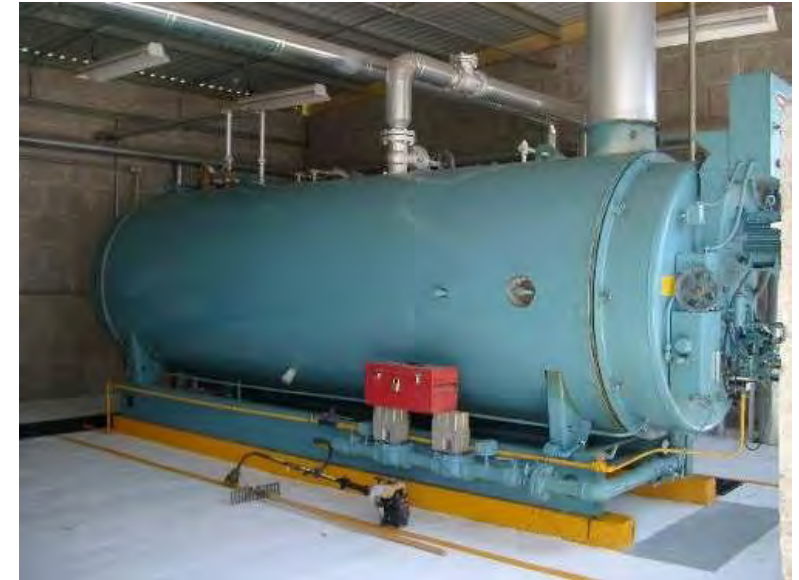
Fijación de Equipo en base de concreto anti vibratoria.
