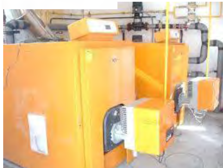
Fijación de Equipo en base de concreto anti vibratoria.
