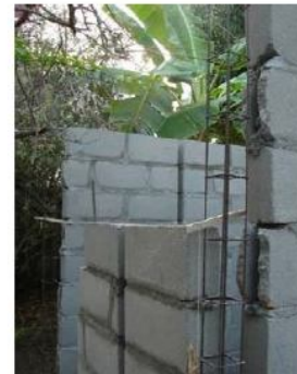
FOTO III. 2. MURO NORTE DEL SISTEMA ARQUITECTÓNICO.
