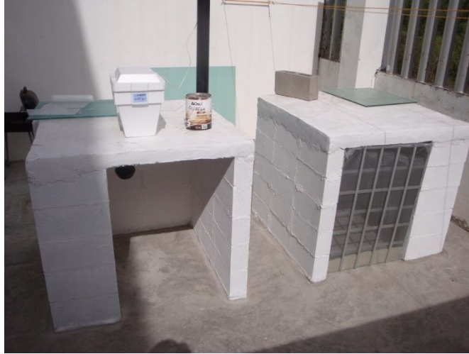
Fig.73. Vista del montaje experimental. Fuente: Propia
