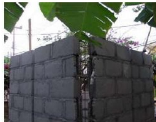
FOTO III. 1. CONSTRUCCIÓN DE LOS MUROS.
