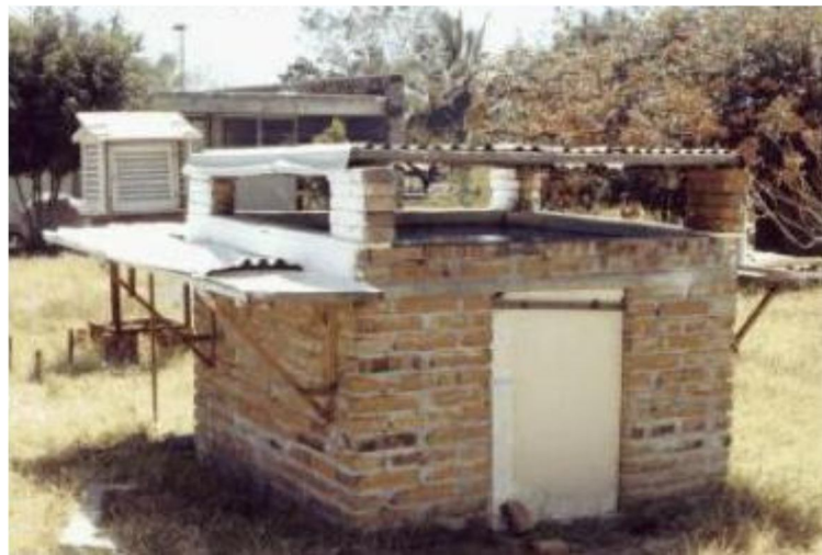
Fig. 24. Modelo de techo estanque, Colima Fuente: González (2011)
