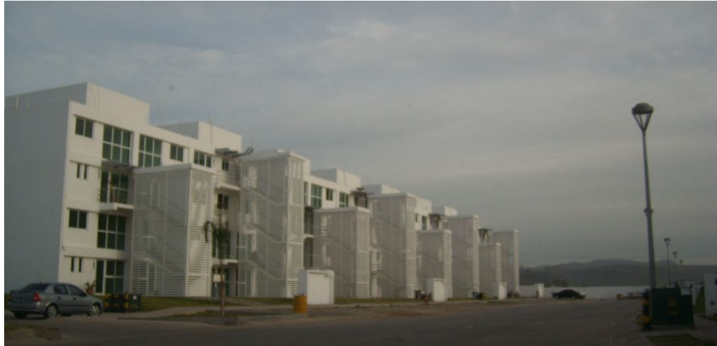
Fig. 55. Vista de la Colonia donde se hará la construcción de las células de estudio. Fuente: Propia.
