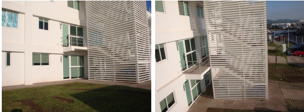
Fig. 56. Vista del edificio donde se harán las mediciones. Fuente: Propia.
