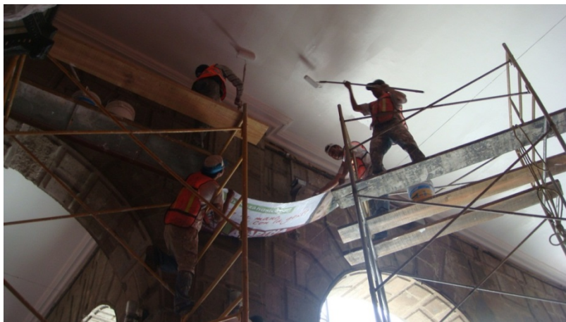
Figura 5.6 Trabajos de aplicación de pintura
