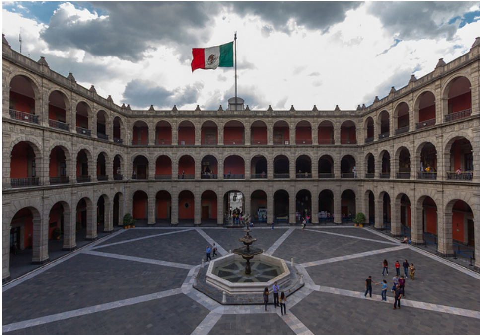
Figura 2.2 Patio central del Palacio Nacional.
