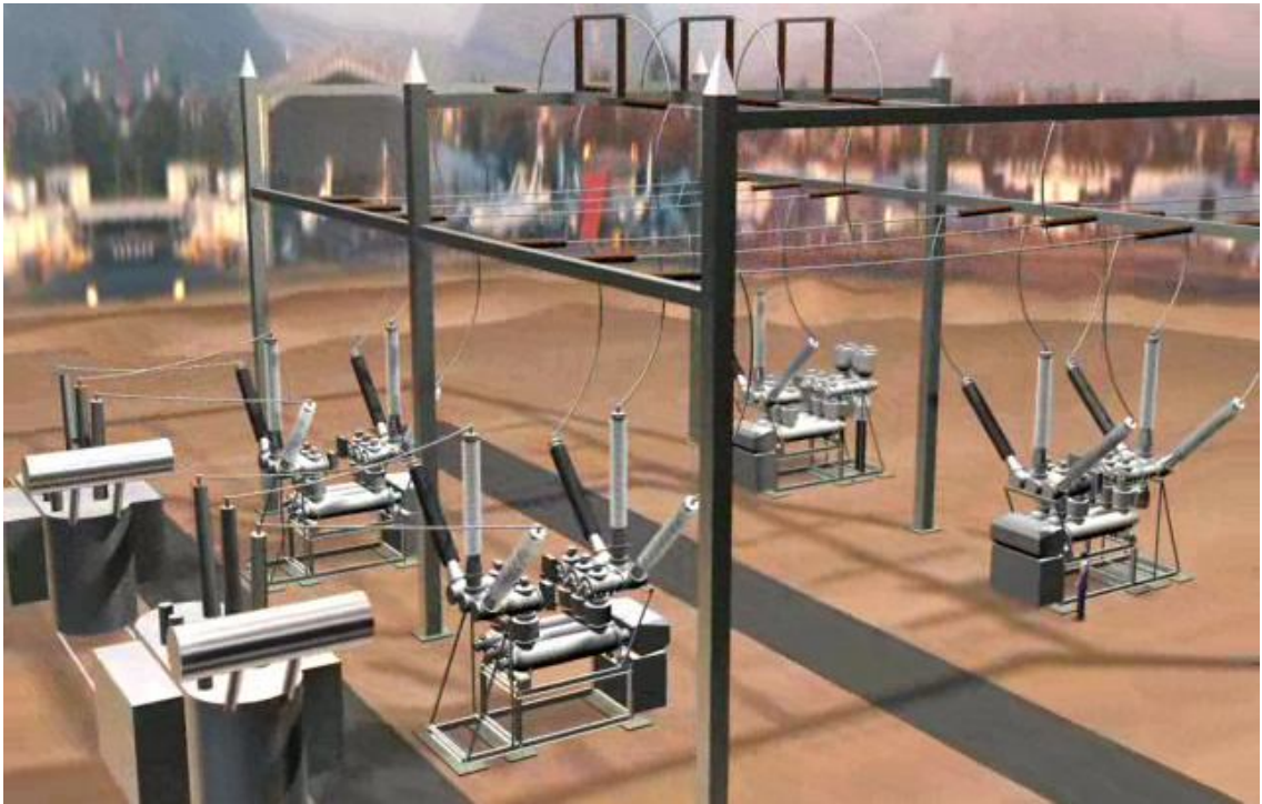
Fig. 2.18. Subestación Eléctrica de Potencia Híbrida con 4 Módulos.
