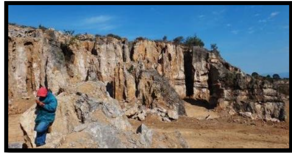
II-B. Fracturas en el área 3, casi verticales con estratificación horizontal.
