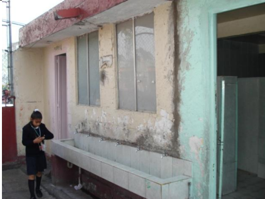
Ilustración 19 Tuberías tapadas en lavamanos
