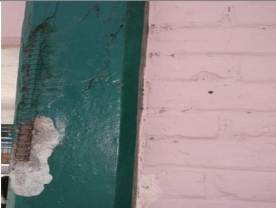
Ilustración 3 Exposición del acero estructural
