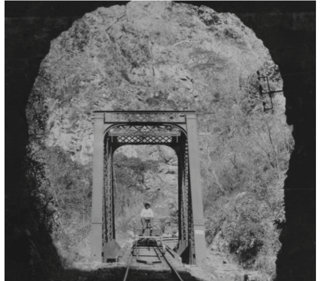
[32] Puente metálico, en el pueblo del Naranjo. Fuente: Fototeca del Centro de Documentación Ferroviaria CEDIF, Museo de los Ferrocarriles de Puebla.
