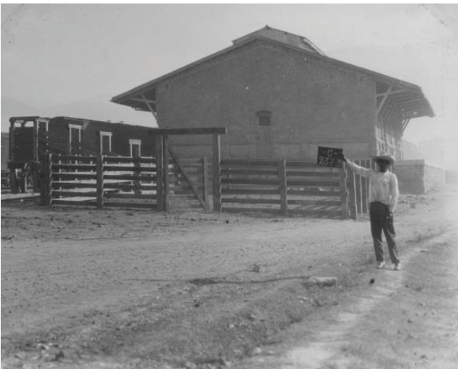
[26] Bodega para carga en Iguala, lado norte. La bodega fue una parte importante para el funcionamiento del conjunto, ya que en esta se guardaban los granos que se transportaban de otras regiones del estado, 1926. Galería de fotografías de Ferrocarriles Nacionales de México. Fuente: Fototeca del Centro de Documentación Ferroviaria CEDIF, Museo de los Ferrocarriles de Puebla.
