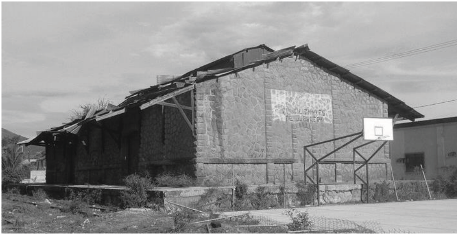
[65] Estado actual de la bodega.
