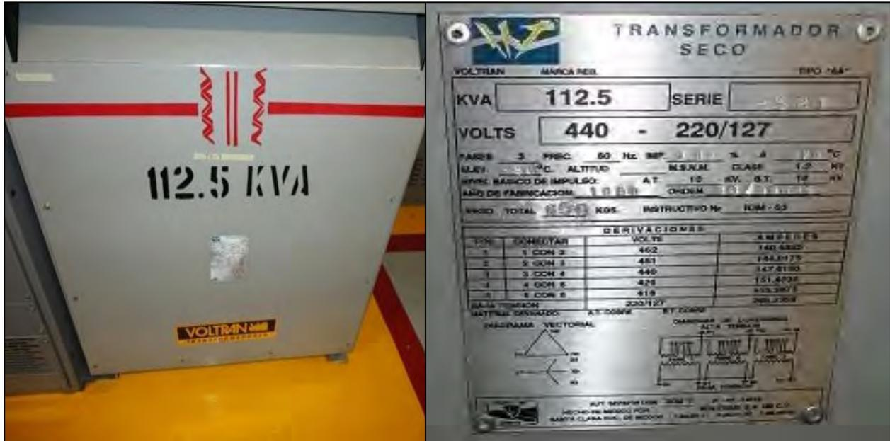
Figura 4.3 Transformador secundario #2, capacidad de 112.5 kVA, 440 - 220/127V marca VOLTRAN instalados en el caso de estudio
