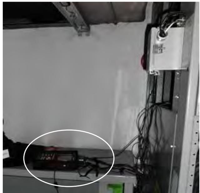
Figura 4.12 Analizador de redes Instalado en Trans. #1
