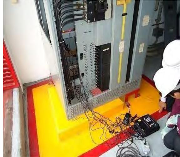
Figura 4.36 Instalación de analizador de redes
