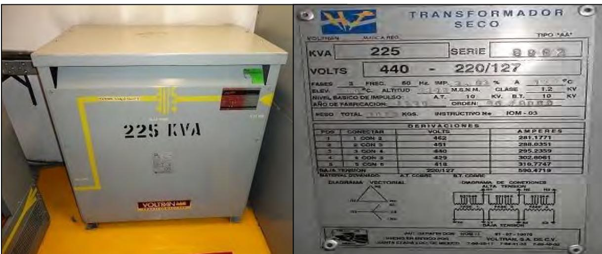
Figura 4.2 Transformador secundario #1, capacidad de 225 kVA, 440 - 220/127V, marca VOLTRAN instalado en el caso de estudio
