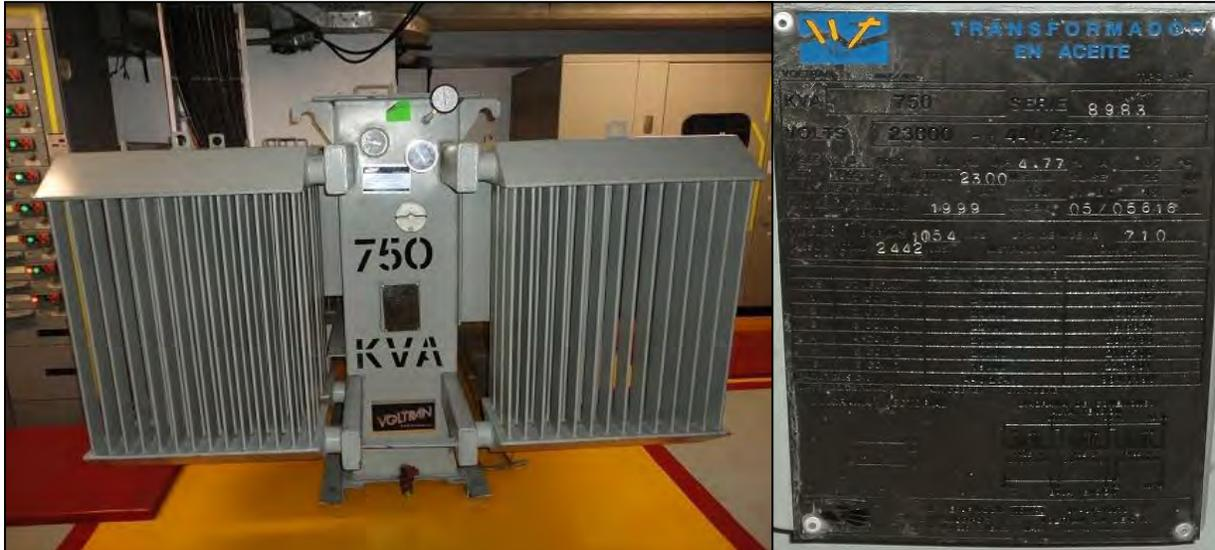
Figura 4.1 Transformador #1, capacidad de 750 KVA, 23kV - 440/254V, marca VOLTRAN instalados en el caso de estudio
