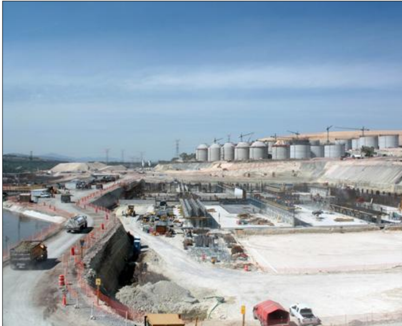
Figura 3. Vista panorámica de avance de obras de la PTAR Atotonilco
