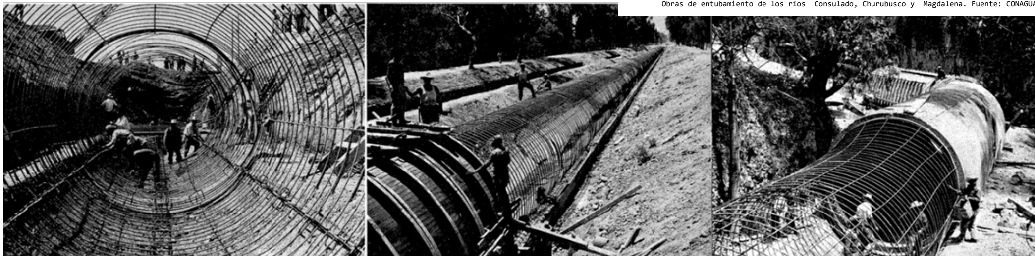
Obras de entubamiento de los ríos Consulado, Churubusco y Magdalena. Fuente: CONAGUA.
