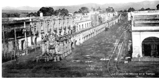
PÉRDIDA DE ABASTO DE AGUA POTABLE
