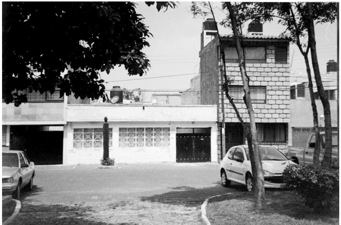
Imagen 14.- Vista de las fachadas principales de las casa de la Unidad Balbuena, se pueden ver Claramente las modificaciones, inclusive una vivienda en dos niveles.
