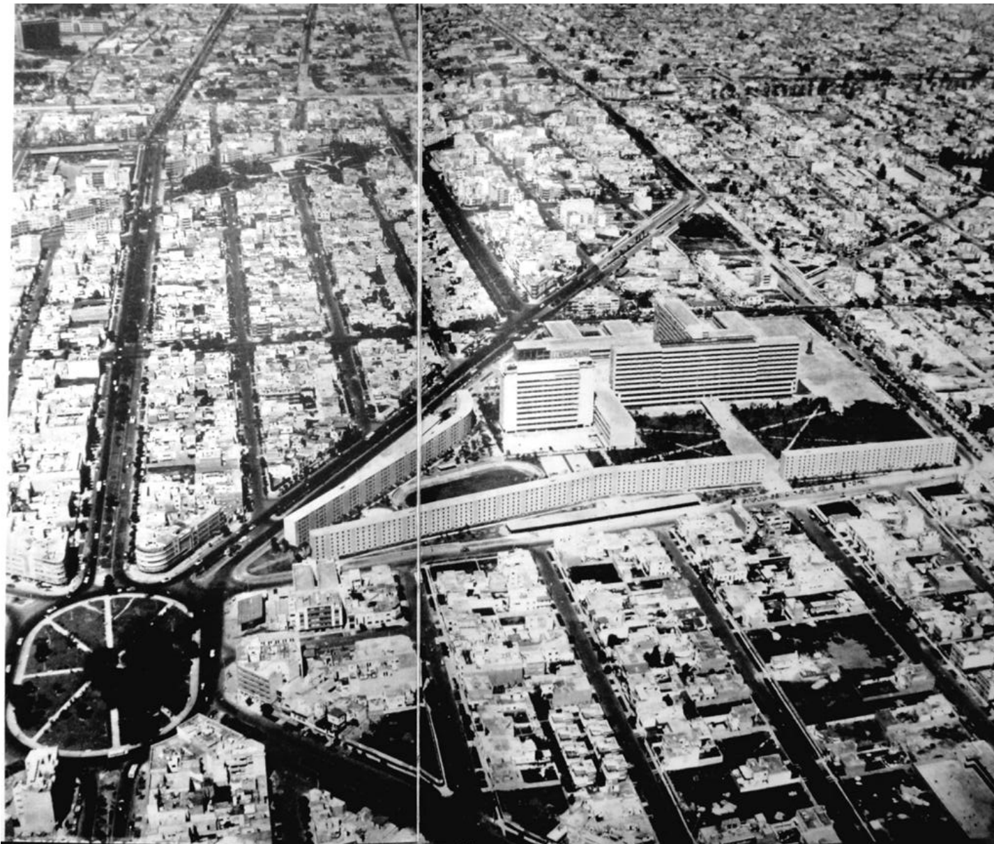
Imagen 35.- Conjunto de la Secretaría de Comunicaciones y Obras Públicas, SCOP. Se observan los edificios de vivienda que rodean el conjunto.
