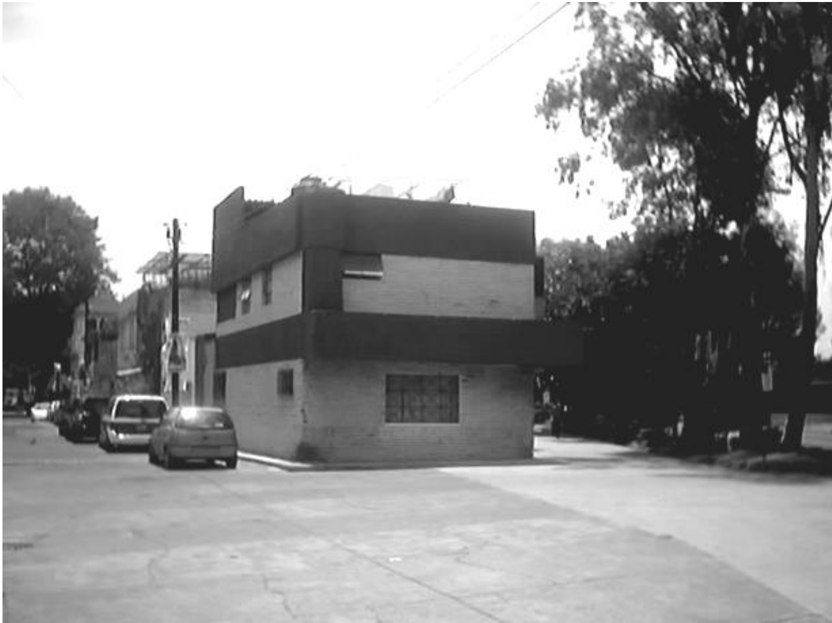
Imagen 25.- Vivienda de la unidad habitacional San Jacinto en la cabeza de manzana que forman las calles de: Ferrocarril de Curnavaca Antúnez y Flores Magón. Se puede ver que la construcción es reciente.
