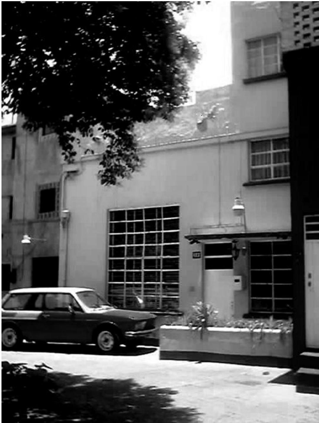
Imagen 27.- Casa de la Unidad San Jacinto, la cual conserva el proyecto de la casa tipo 2-A y los materiales Originales, es la única vivienda de las dos unidades Balbuena y San Jacinto en su estado original, se puede ver la jardinera del vestíbulo exterior.
