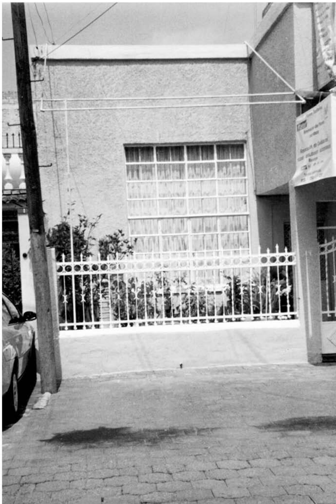
Imagen 18.- Casa de la calle de cincel No. 6 la cual es la única de la Unidad Balbuena que conserva parte de la fachada y el cancel de la ventana originales, le añadido en la planta alta un añadido hasta el alineamiento del terreno que esta sobre la calle.
