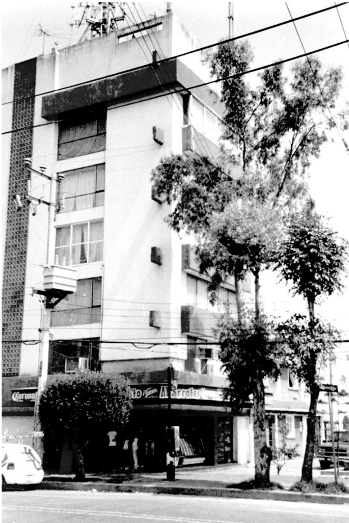
Imagen 20.- Edificio construido en la esquina de las calles: Yunque y Martillo de la unidad habitacional: Balbuena. La construcción ocupa cuatro de los lotes originales.
