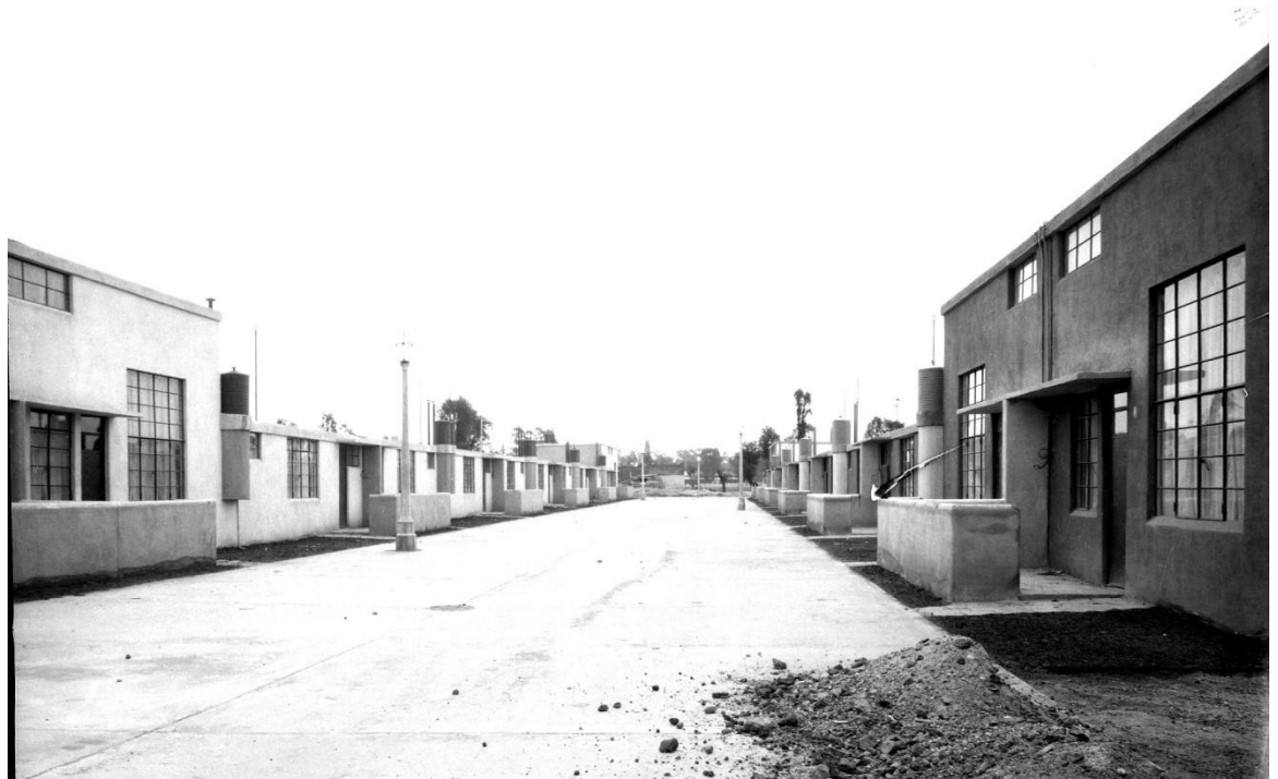
Imagen 10.- Vista de las fachadas principales de las casa de la Unidad Balbuena, se pueden ver Claramente los tinacos en las azoteas de las casa símbolo de contar con agua corriente.
