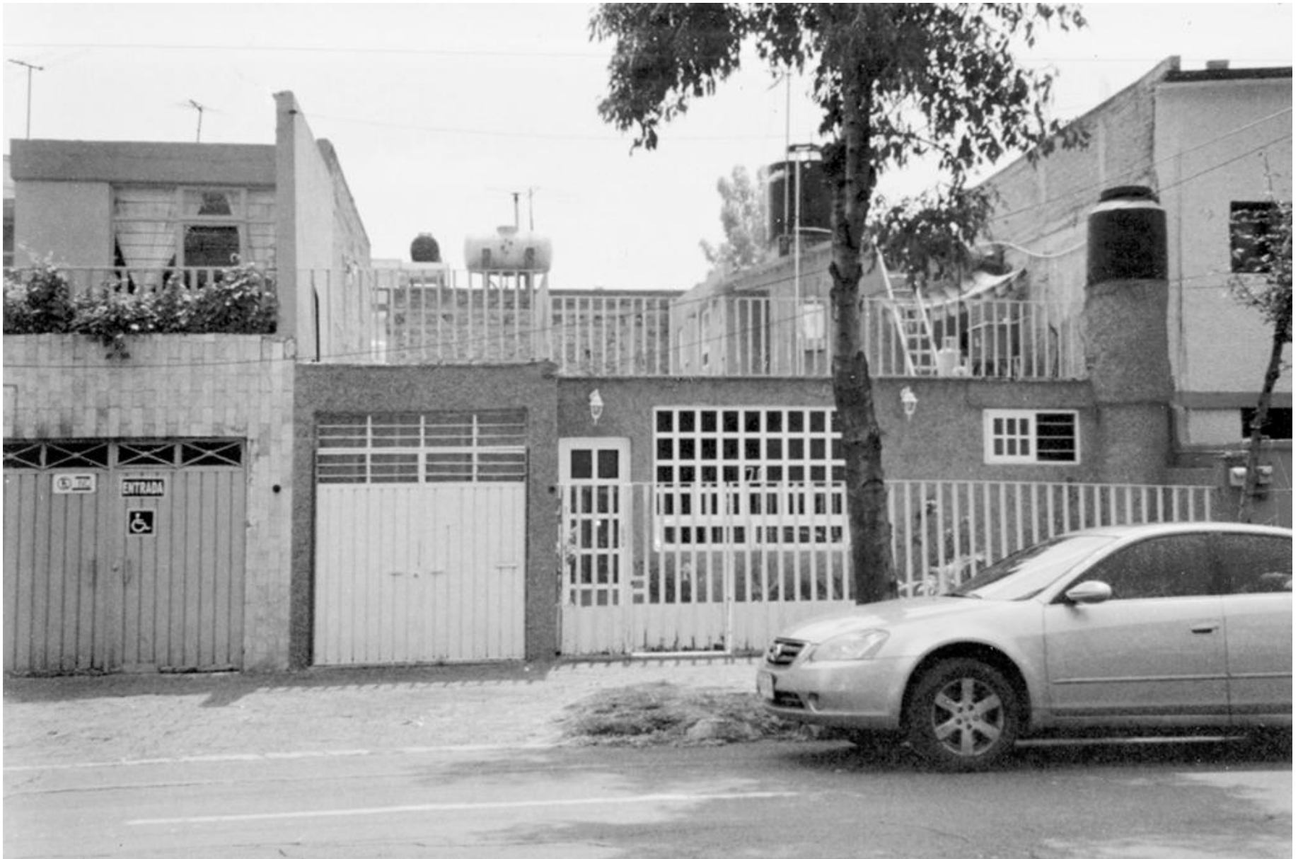
Imagen 19.- Vivienda de la unidad habitacional Balbuena, conserva el esquema del proyecto original, se ve aún el cilindro en el que descansa el tinaco del agua y en el cual originalmente se encontraba el calentador del agua, la cancelería fue modificada.
