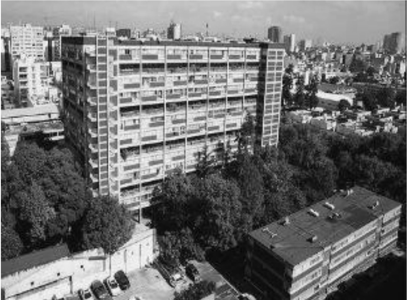
Imagen 33.- Edificio del: Conjunto urbano Miguel Alemán.
