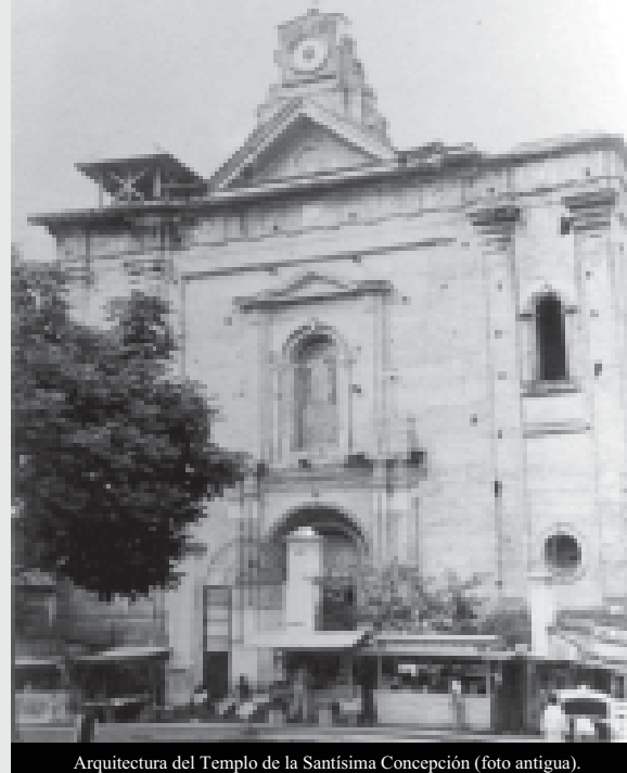
Arquitectura del Templo de la Santísima Concepción (foto antigua).
