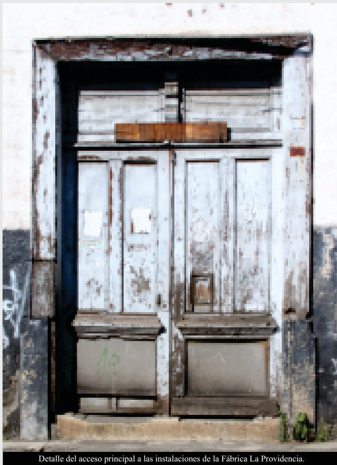
Detalle del acceso principal a las instalaciones de la Fábrica La Providencia.
