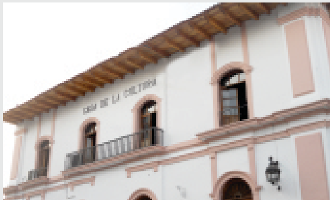
Detalle arquitectónico de la Casa de la Cultura en Uruapan (actualmente en remodelación).
