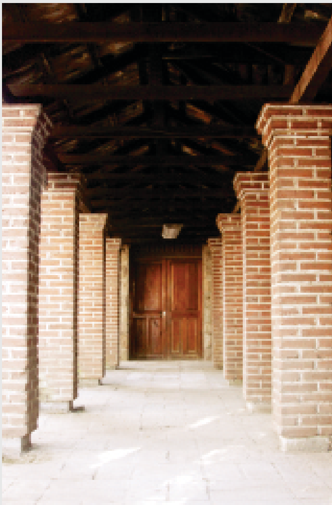
Paseo en el interior de la estación de ferrocarril, conforma su arquitectura una serie de columnas de ladrillo y envigados de madera en el techo.
