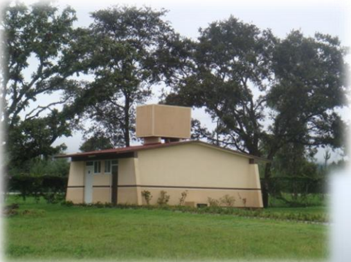
Núcleo de Sanitarios.
