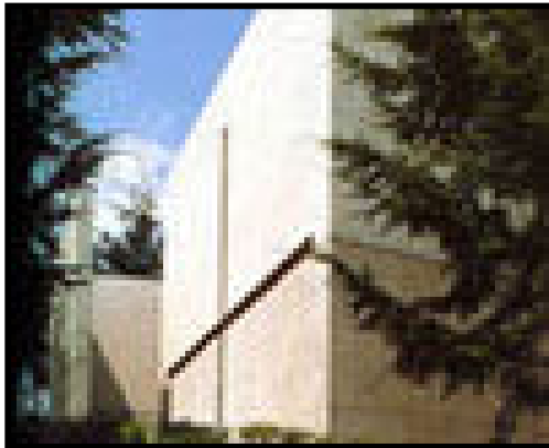
FIGURA 46. Fachada lateral de la iglesia de la luz.
