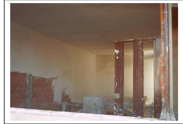
Aplanado en Muros.
