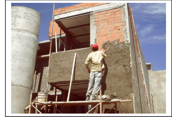
Aplanado Muros Planta Alta.
