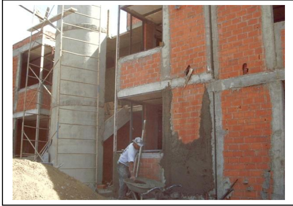
Aplanado Muros Planta Baja.
