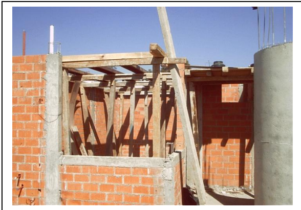
Colocación de Cimbrado.
