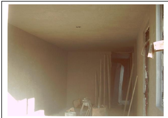
Emboquillado de Puertas y Ventanas.
