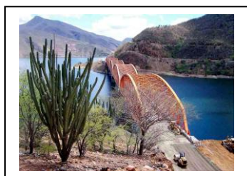
Carretera Uruapan Lázaro Cárdenas.
