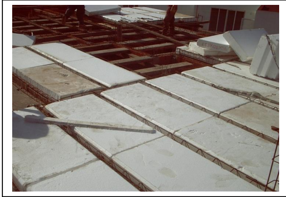
Colocación de Casetón.
