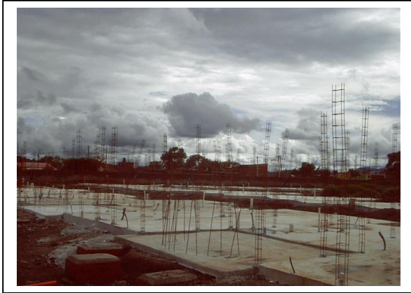
Trazo de Muros.
