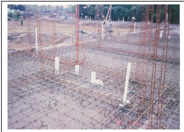
Instalación hidrosanitaria.
