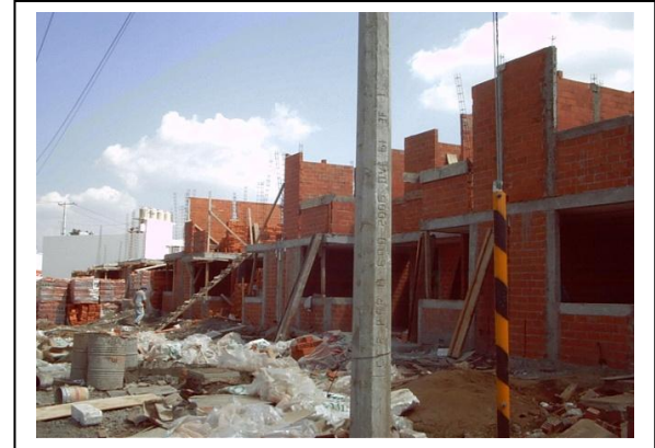
Colado de Castillos.
