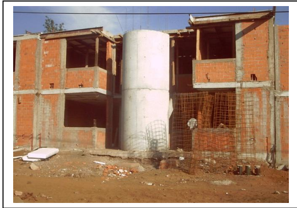
Cimbrado de Losa de Azotea.
