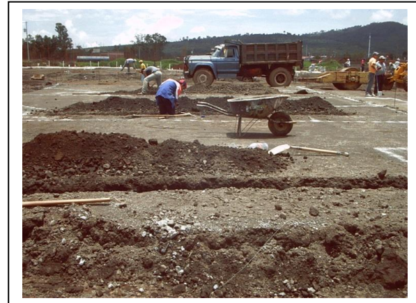
Excavación de Plataforma para Albañales.
