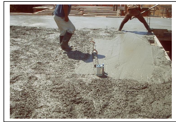
Nivelación de Losa.
