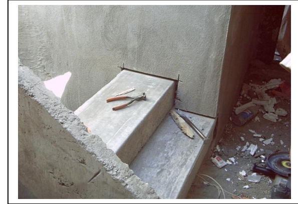
Ensamblado de Escalones.
