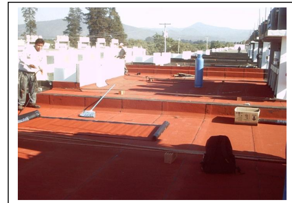
Terminado de Colocación Asfáltica.
