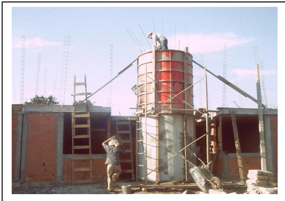
Cimbrado de Cilindro de Escalera.
