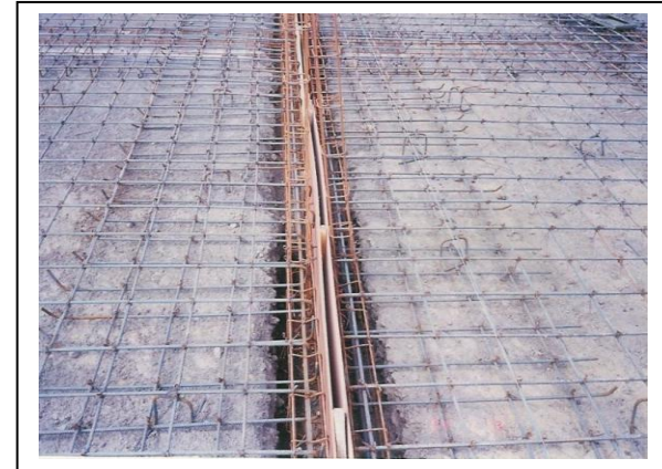
Junta Constructiva entre Cimentaciones.
