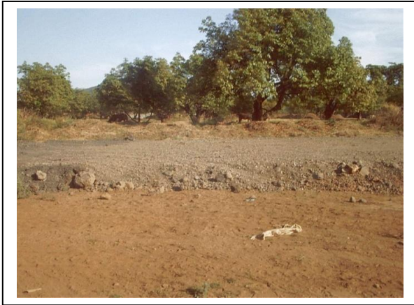
Colocación de Filtro.
