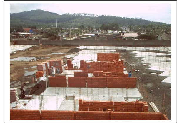
Desplante de Muros.
