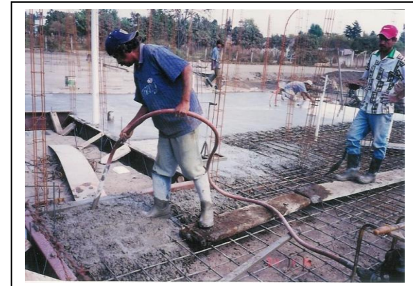
Anclaje de Castillos y Colado de Losa.
