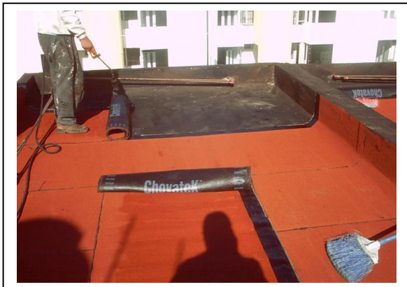
Colocación de Cinta Asfáltica.
