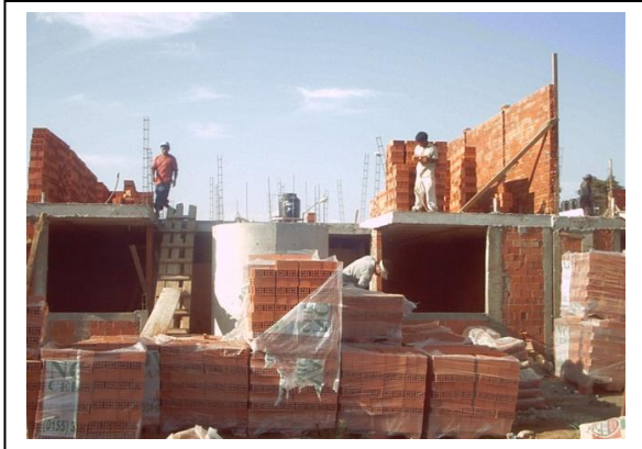
Desplante de Muros Planta Alta.
