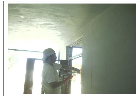
Limpieza de Puertas y Ventanas.
