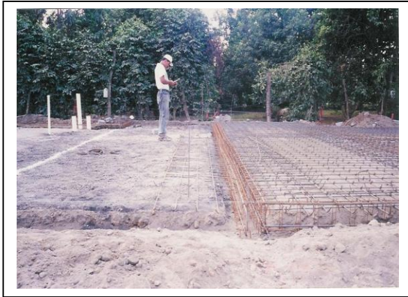
Plataforma y Losa de Cimentación.
