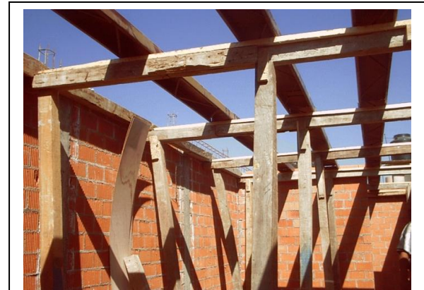
Colocación de Cimbra de Madera.
