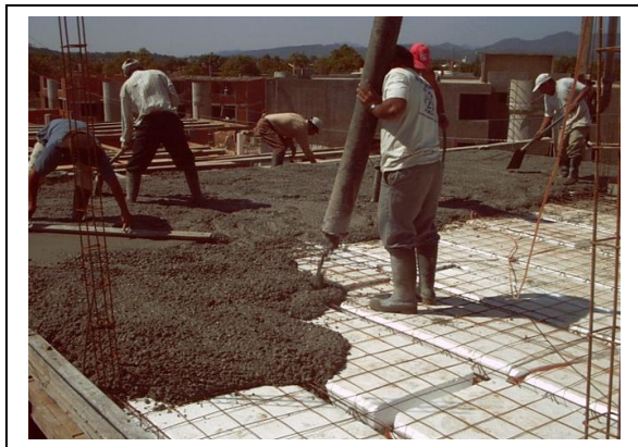
Colado de Losa de Azotea.
