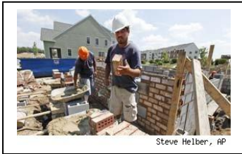
Construcción de Vivienda
