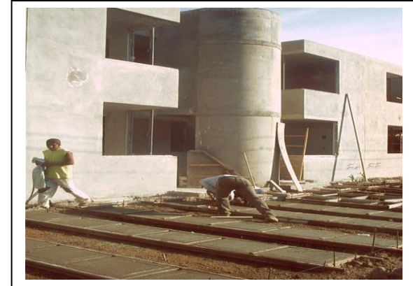
Colado de Huellas.
