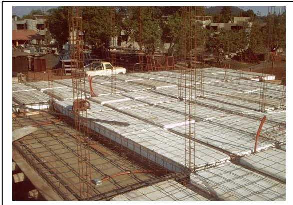
Inst. Eléctrica y Sembrado de Castillos.
