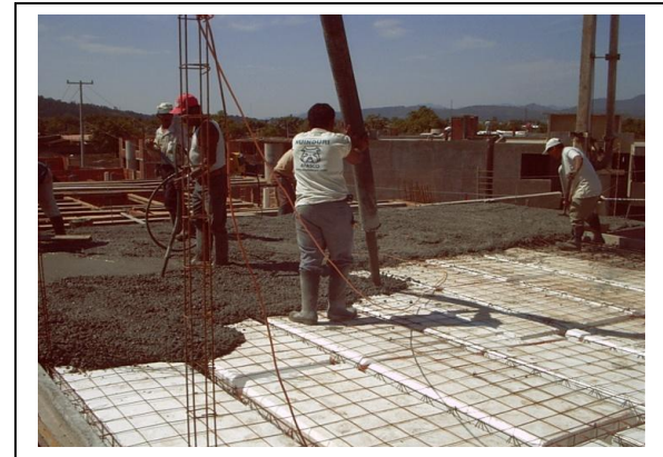
Colado de Losa de Entrepiso.
