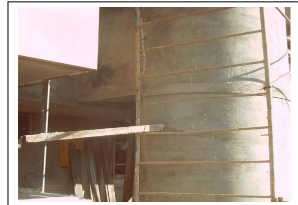
Terminación de Cilindro de la Escalera.
