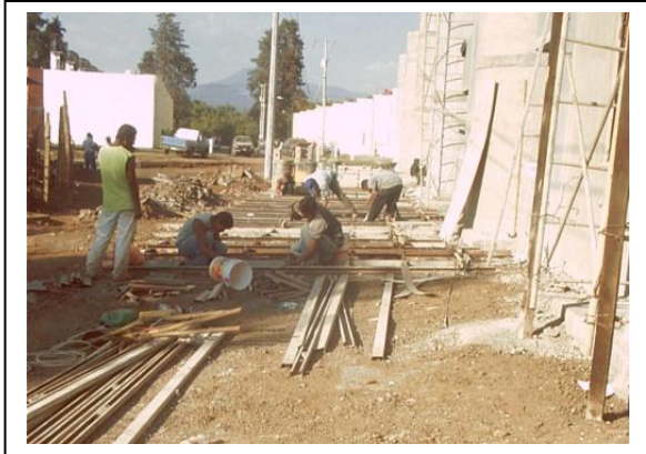
Nivelación y Habilitado de Huellas.
