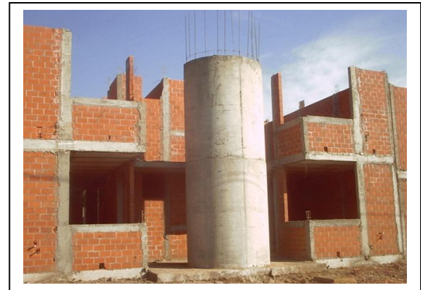
Colado de Cilindro de Escalera.
